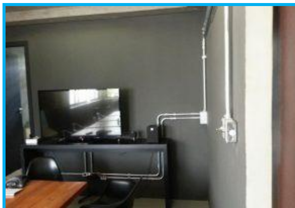
Figura 2 - Eletroduto aparente branco.
