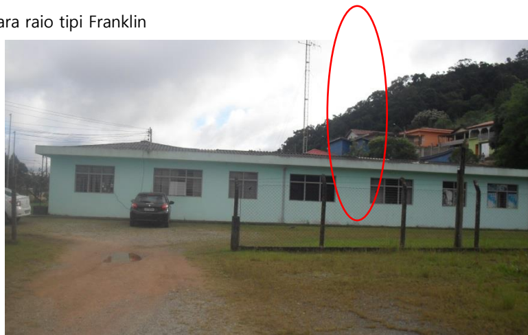
Foto 14 – Torre do Rádio com Para raio tipo Franklin
