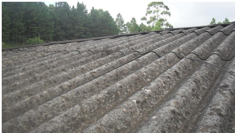
Foto5 – Estrutura sem ondulações
