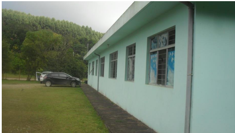
Foto 21 – Fachada lateral direita
