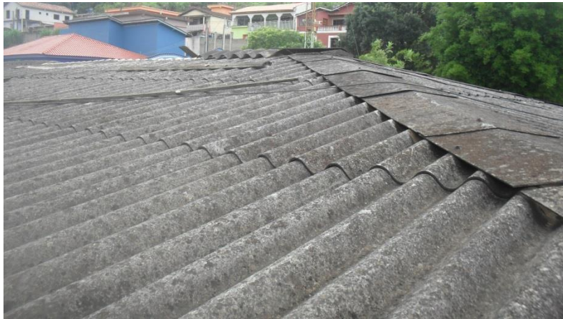
Foto4 – Cumeeiras em bom estado
