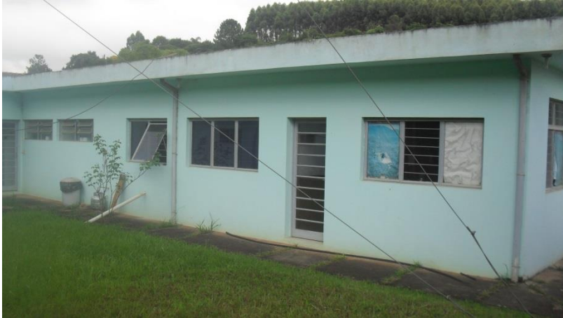
Foto 8 – Esgoto da Pia
