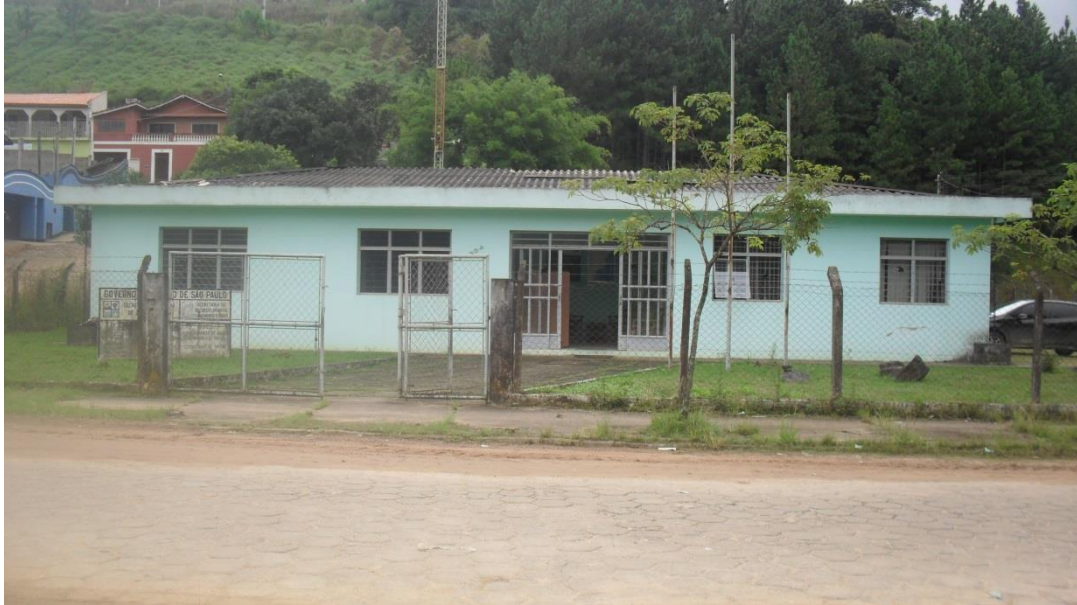
Foto 1 - Fachada Principal da Sede Administrativa
