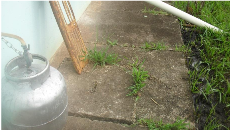
Foto 11 – Caixa de gordura a ser desativada
