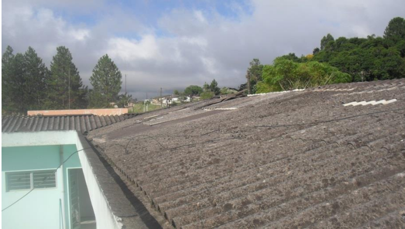
Foto6 – Calhas em bom estado
