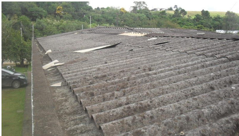
Foto 7 – Revisão de telhas e cumeeiras
