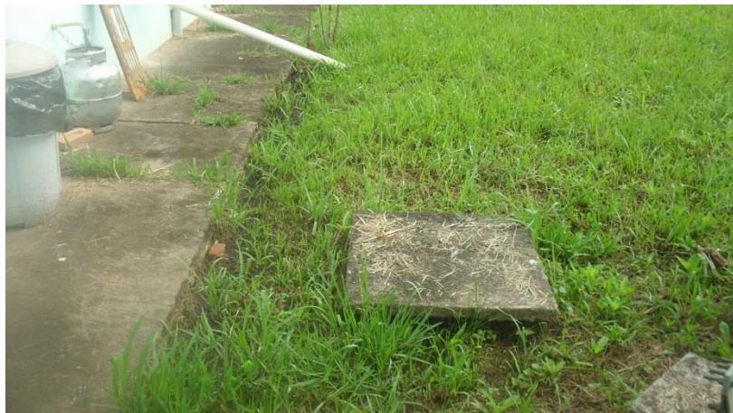
Foto 12 – Caixa de inspeção a ser desativada
