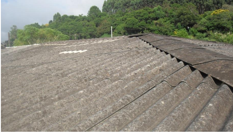
Foto3 – Boa conservação das telhas
