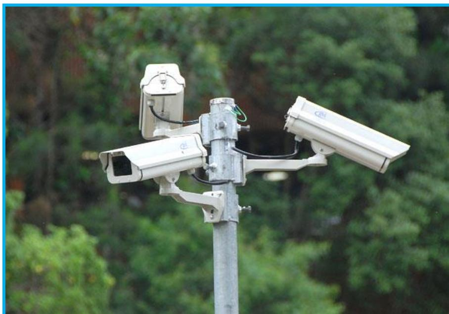
*Figura 2 – Exemplo de poste metálico com suporte para câmeras.*
