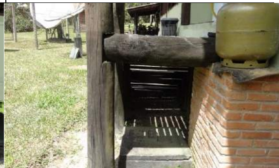
Detalhe do caixa de gordura
