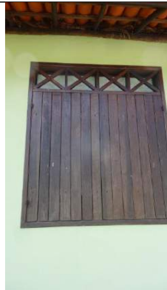
Janelas em bom estado
