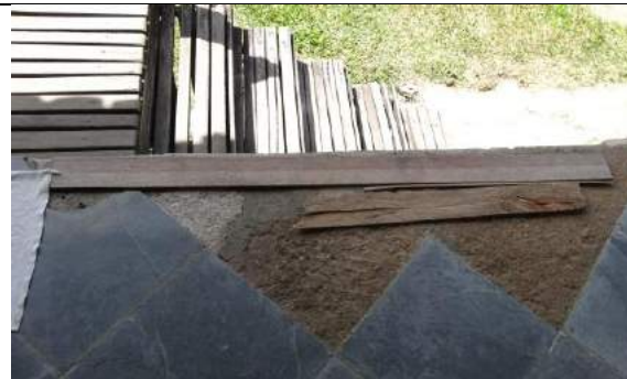
Reposição do piso de ardósia
