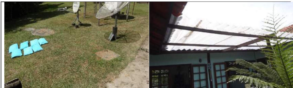
Limpeza das caixas de inspeção e fossa séptica
