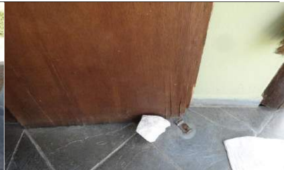
Porta de acesso a área de serviço
