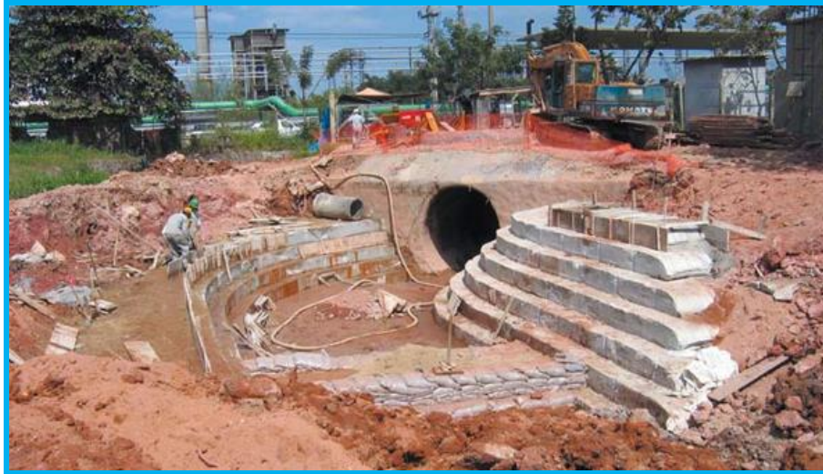
Figura 3 - Exemplo de uso de bolsas de concreto (Rip-Rap) em sistema de drenagem.
