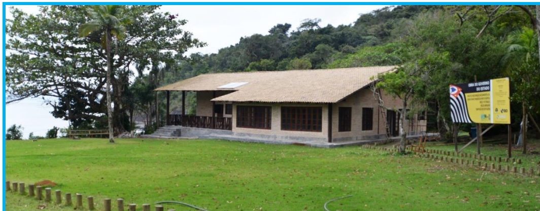
Figura 2 – Fachada da Base de Proteção.
