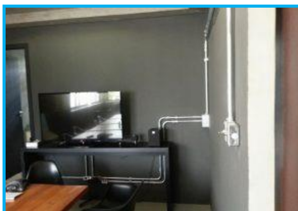
Figura 2 - Eletroduto aparente branco.
