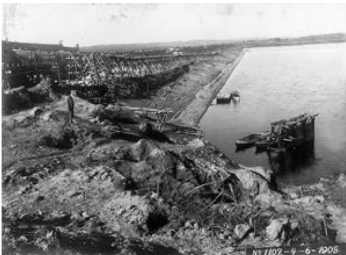
FIGURA 22. Obras na barragem de Santo Amaro, 1908
