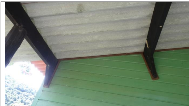
Tratamento do madeiramento da garagem
