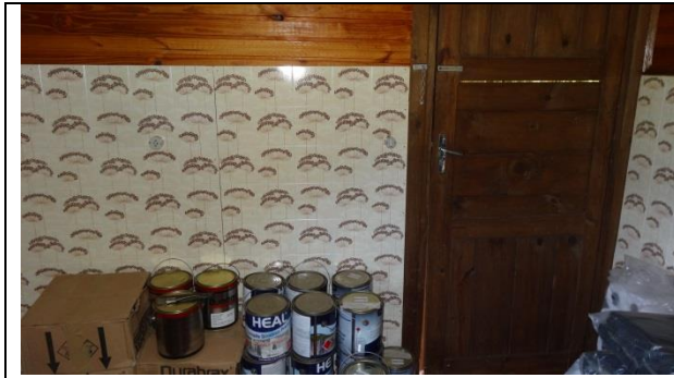
Retirada de revestimento de madeira
