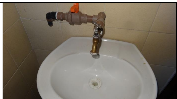
Troca de lavatório
