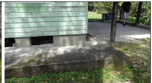
Recuperação da base da edificação com acabamento e pintura
