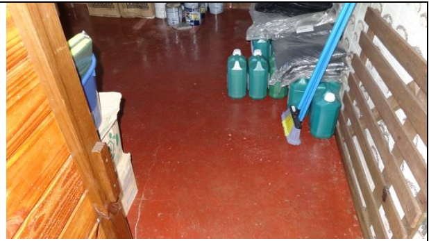
Troca do piso da cozinha
