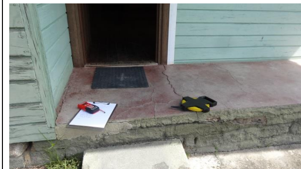
Refazer o calçamento e troca do piso da varanda
