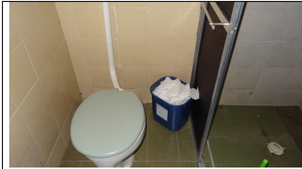
Troca de sanitário
