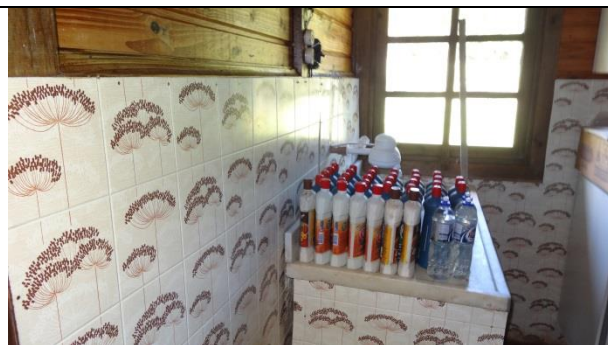
Retirada do revestimento de madeira tipo formica e levantamento de parede de meio tijolo para apoio da pia com armário embutido.
