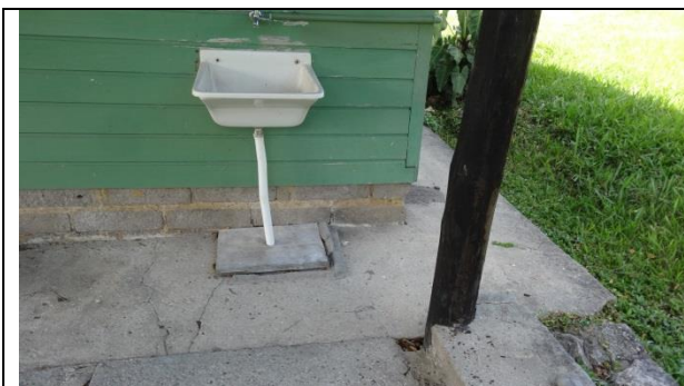
Troca do tanque com coluna
