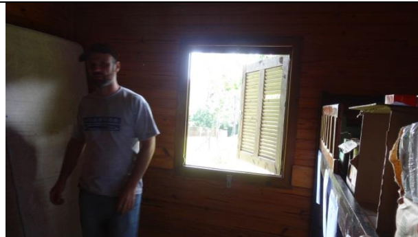
Madeiramento precisando de acabamento
