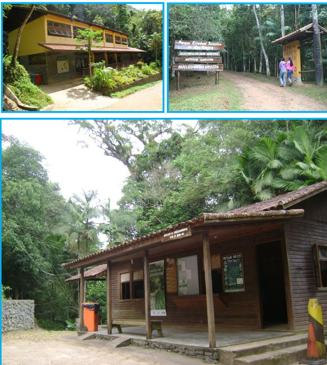
Figura 5 - Fachada do Núcleo Santana.
