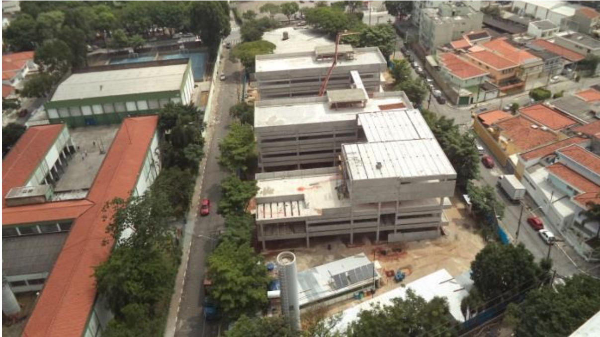
Situação atual da obra
