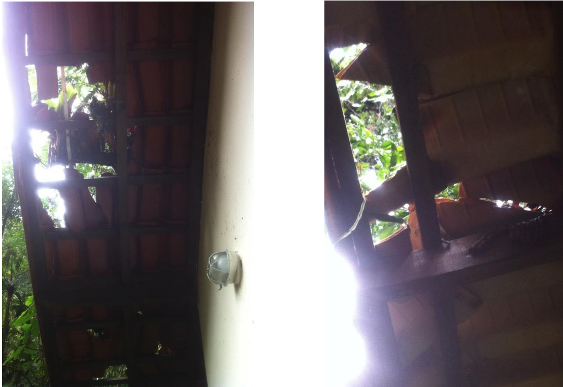
Figura 4. Telhas quebradas fotografadas por baixo.
