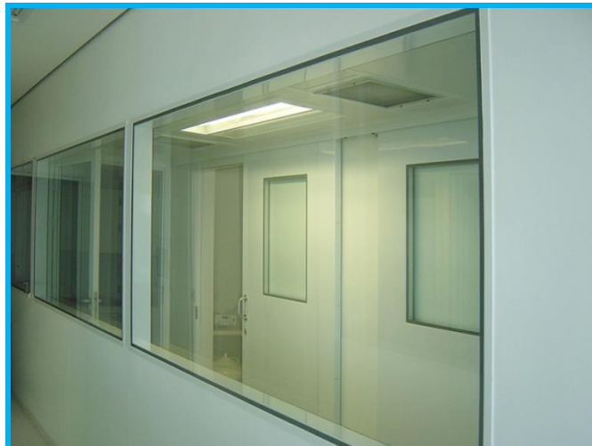
Figura 3 - Exemplo de drywall com visores na extensão
