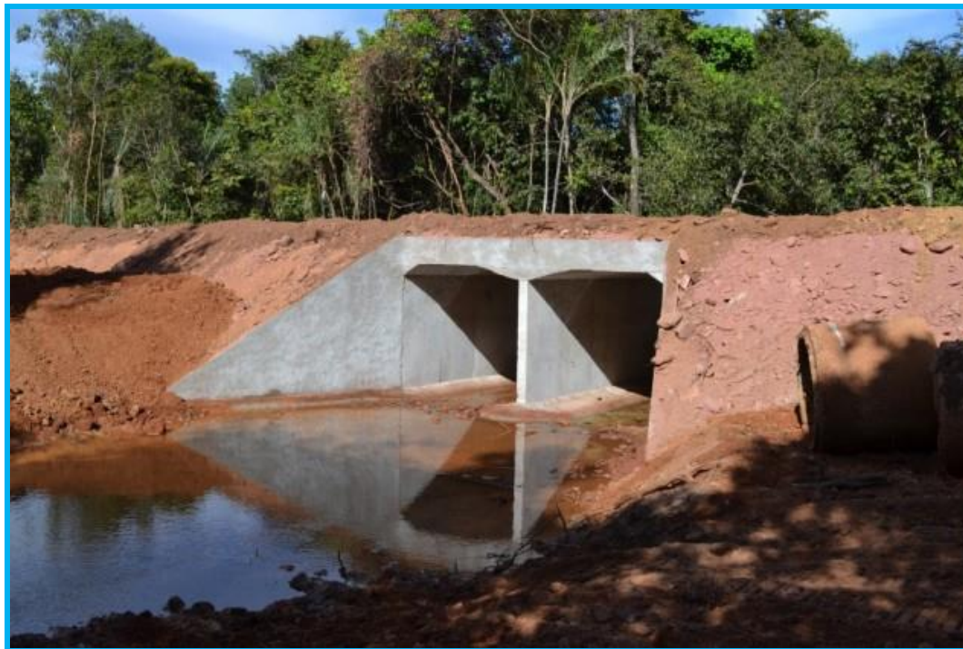
Figura 3 - Exemplo de sistema de bueiro celular.
