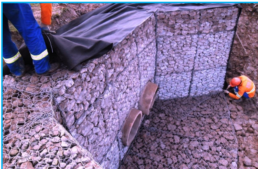
Figura 8 – Exemplo de muro gabião em cabeceira de bueiro.
