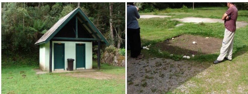
Figura 53 a, b - Sanitário existente na área de uso público; Ponto localizado na área de uso público (muito próximo à rede hidrográfica local), que era utilizado como sanitário.
