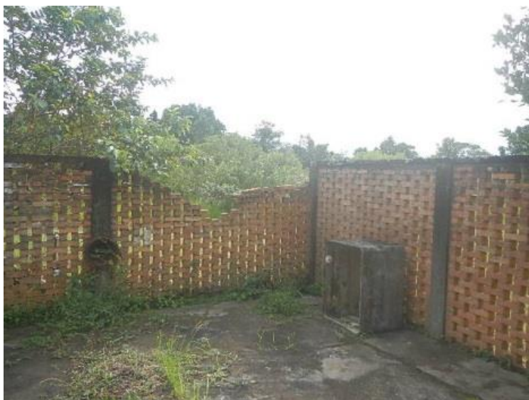
Muro de alvenaria vazada
