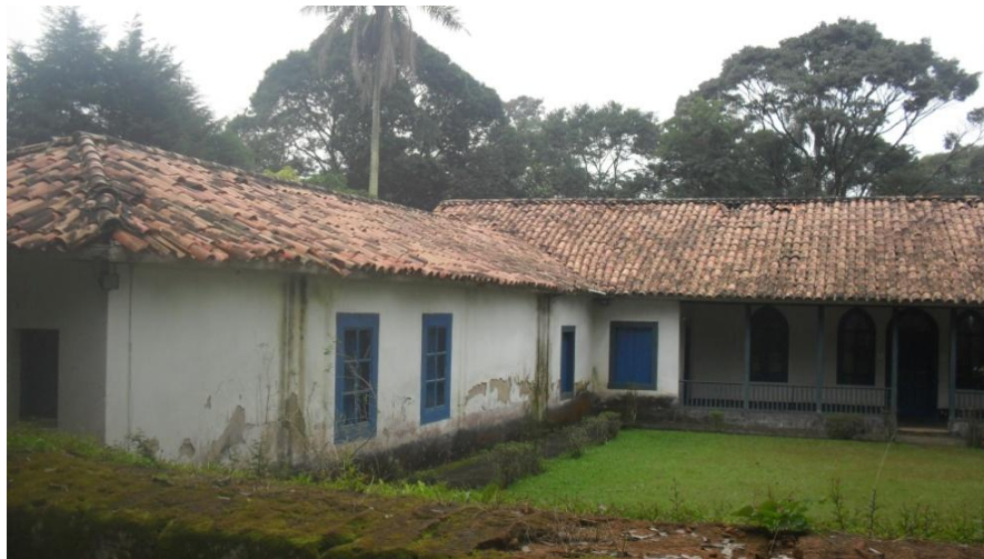
Imagem 02 – Vista geral da lateral do telhado
