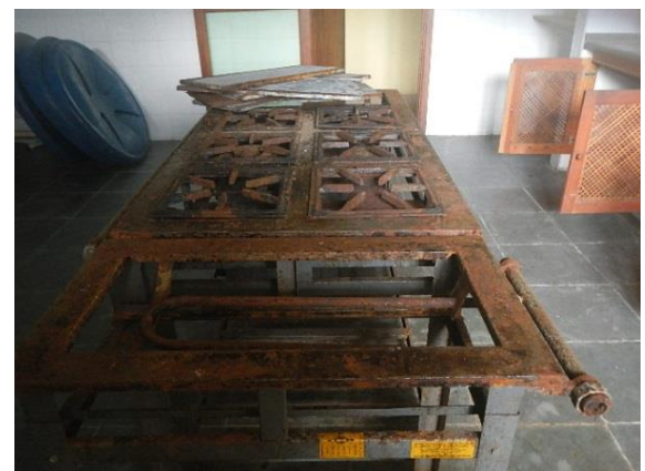
Estado precário do fogão e oferecendo riscos de vazamento
