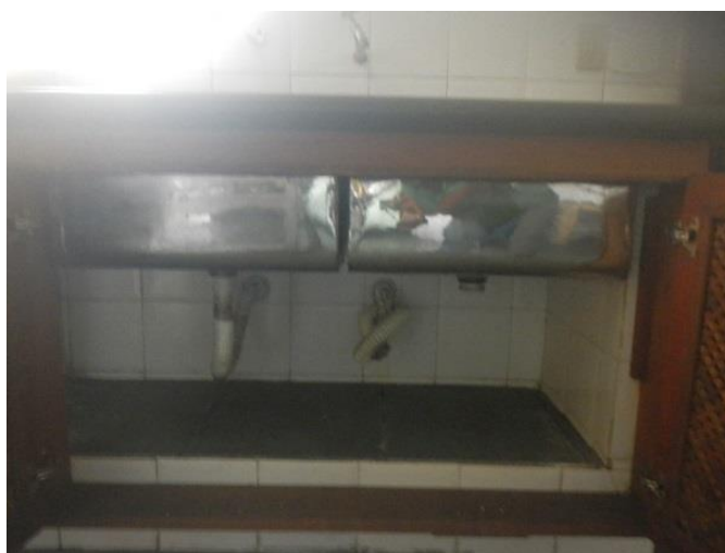
Substituir os sifões
