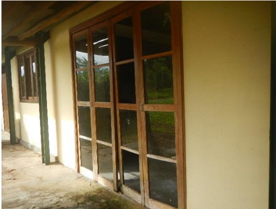
Falta vidro e ajuste de dobradiças e fechamento
