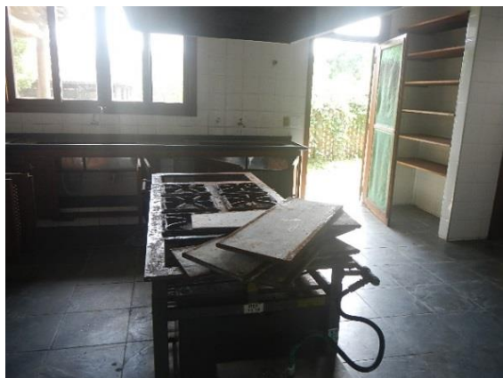
Estado precário do fogão e oferecendo riscos de vazamento
