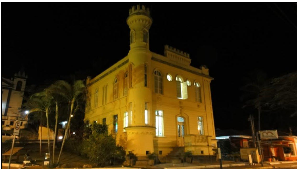
Figura 2 – Vista frontal da sede do PEI.
