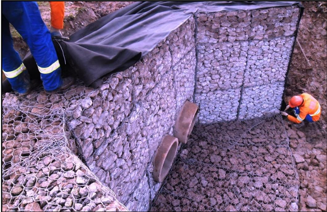
*Figura 8 – Exemplo de muro gabião em cabeceira de bueiro.*
