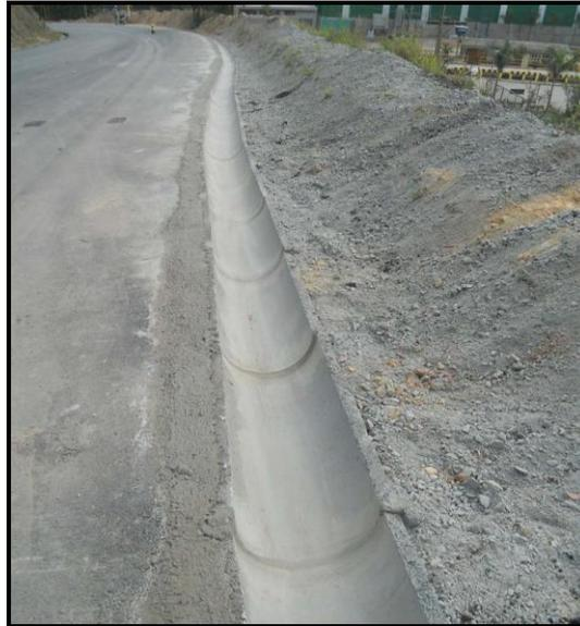
*Figura 9 – Exemplo de drenagem em estrada com meios tubos de concreto.*
