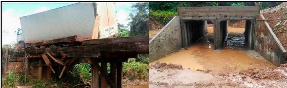
*Figura 4 – Exemplo de substituição de ponte de madeira por bueiro celular.*
