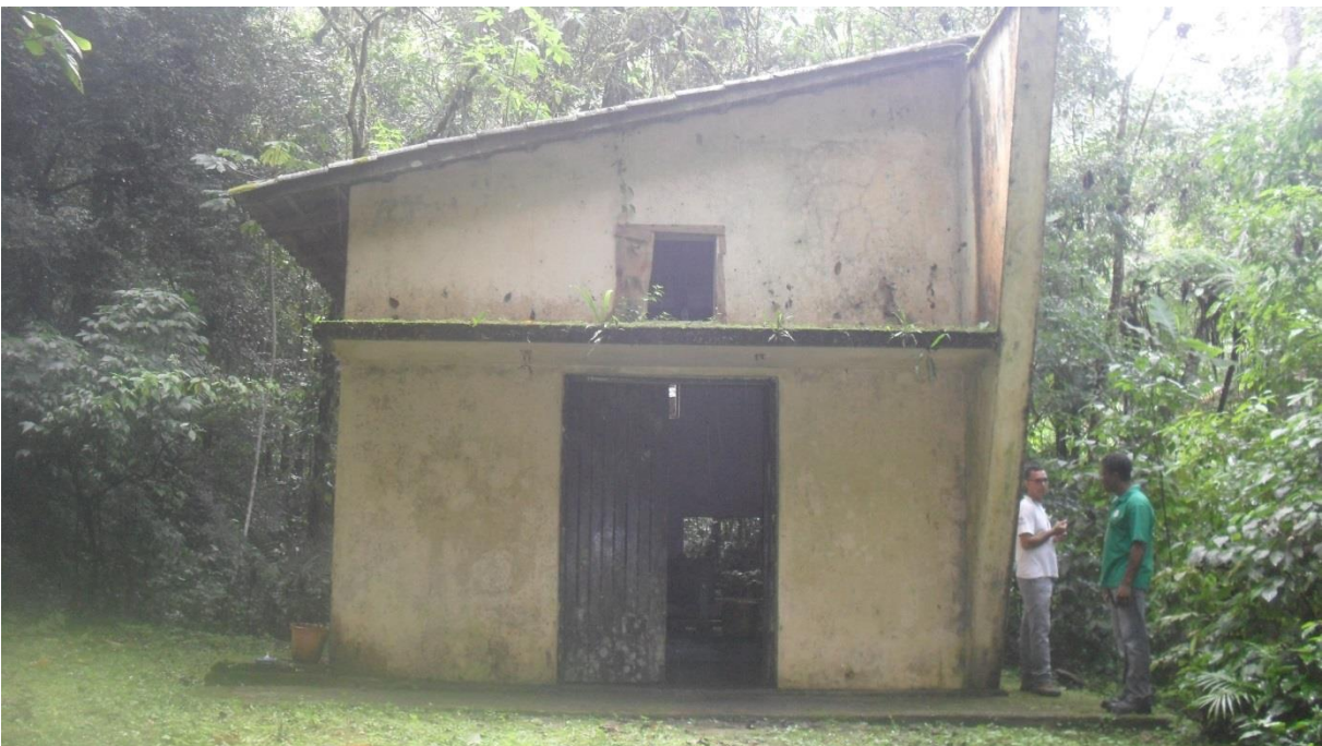
Foto 6 - Fachada Principal Casa dos Geradores
