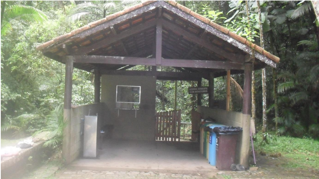
Foto 21 – Vista principal da portaria
