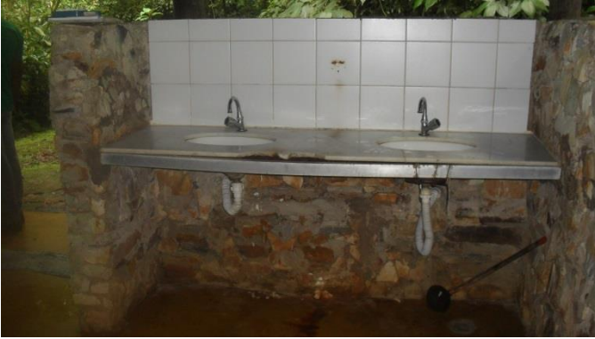
Foto 19 – Lado feminino – Troca da bancada e dos sifões
