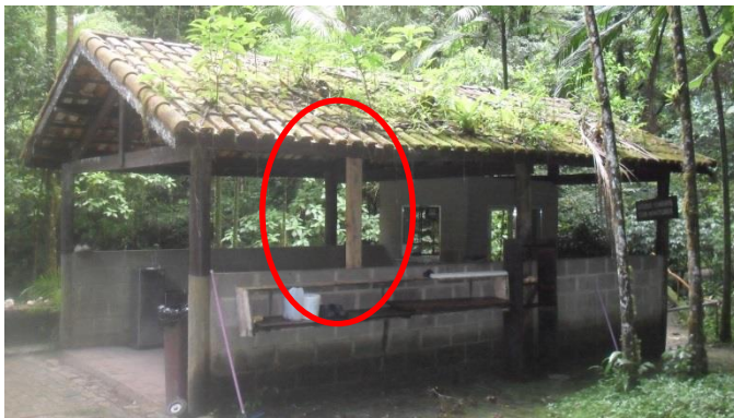
Foto 26 – Escoramento provisório da estrutura. Vãos assimétricos
