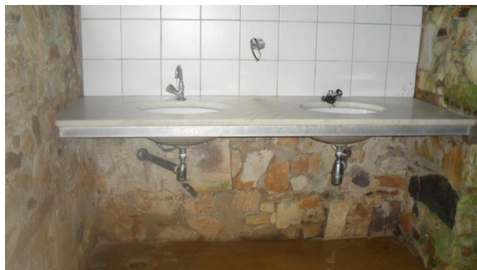
Foto 18 – Bancada do lado Masculino – troca de torneira e sifões
