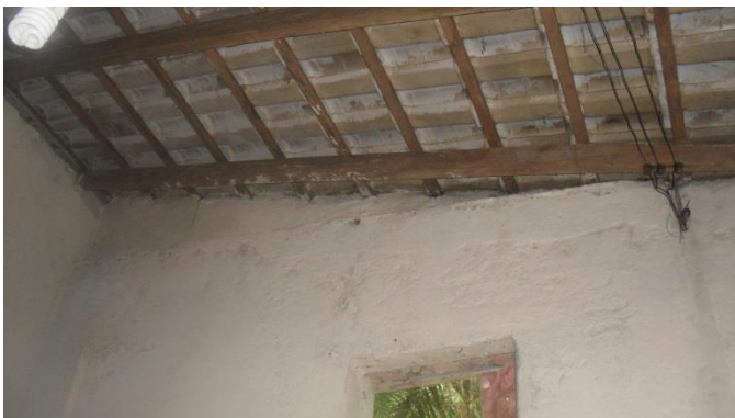
Foto 8 – Estrutura com ripas e caibros
