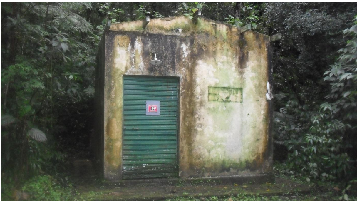
Foto 1 - Fachada Principal Casa do Transformador
