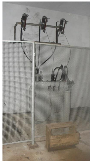
Fotos 2 e 3 – Transformador de tensão e grade de proteção
