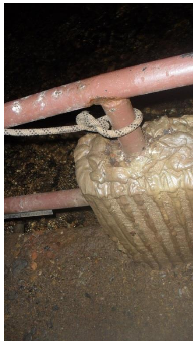
Fotos 30 e 31 – Improvisação com corda na ausência de parte do guarda-corpo
