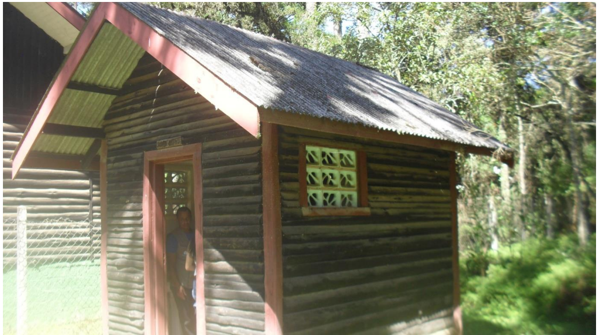
Figura 35 - Substituição das ripas e telhas de amianto por telhas cerâmicas francesas e pintura de toda a área externa
