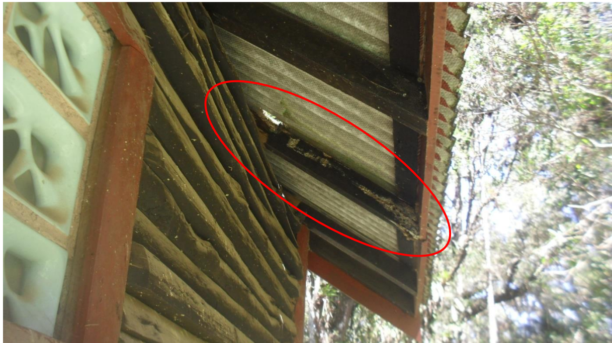
Figura 36 - Substituição de caibros deteriorados
