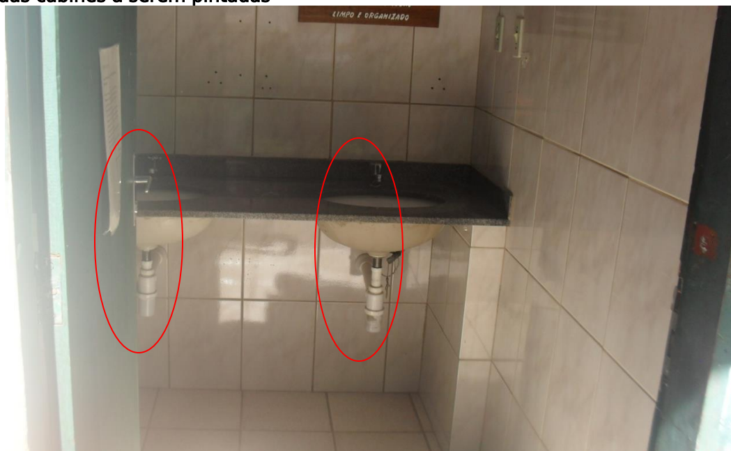
Figura 3 - Substituição de torneiras e sifões, instalação de espelho, saboneteiras e toalheiros
