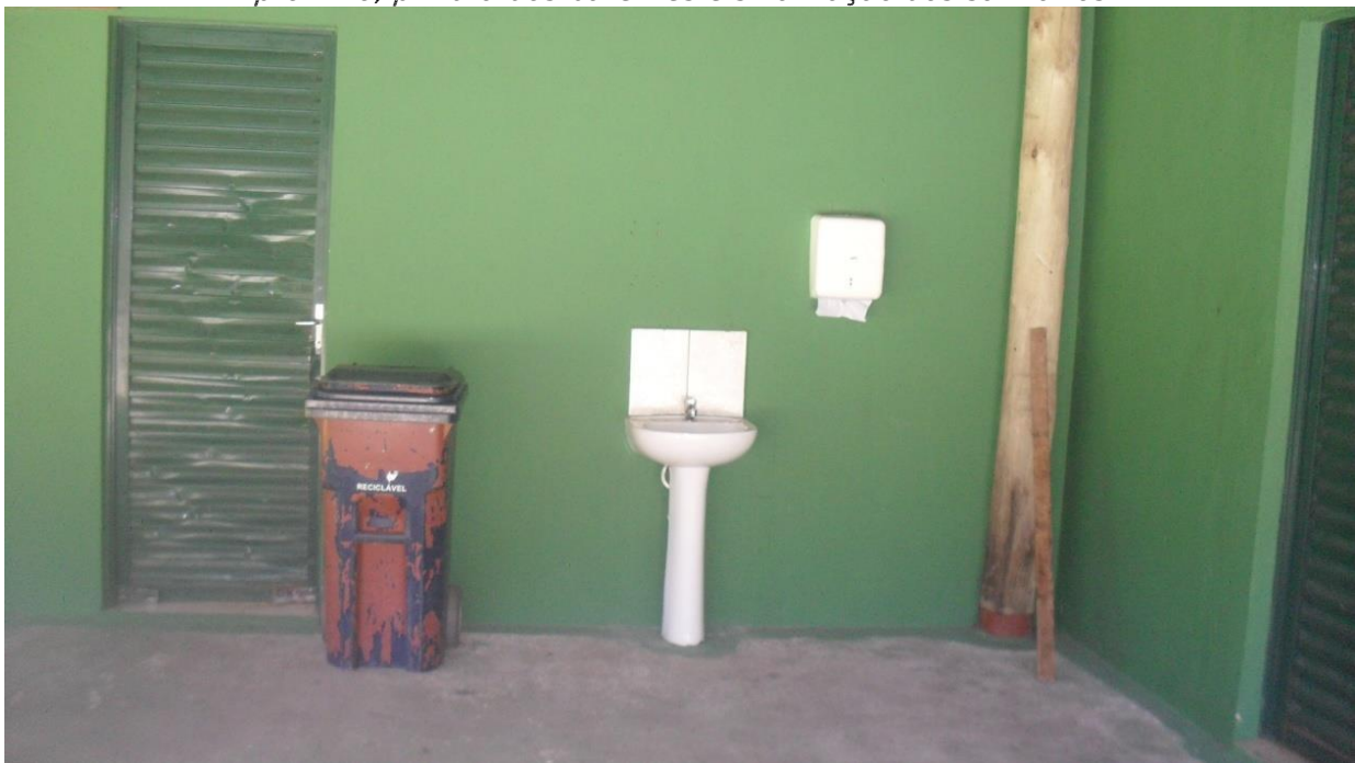
Figura 27 – Substituição de torneira, sifão e instalação de saboneteira
