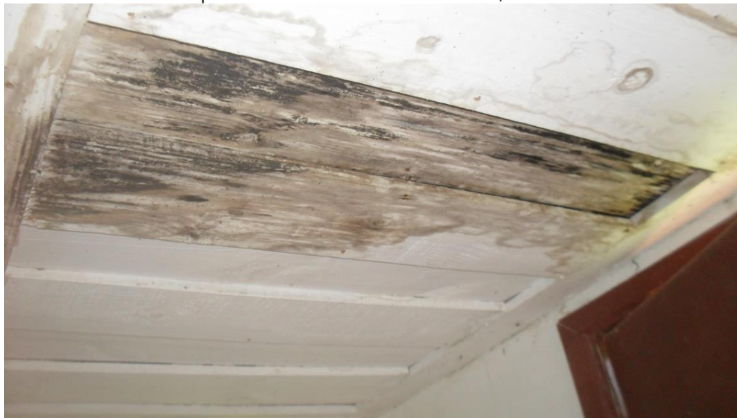
Figura 32 – Substituição de tábuas do forro e pintura
