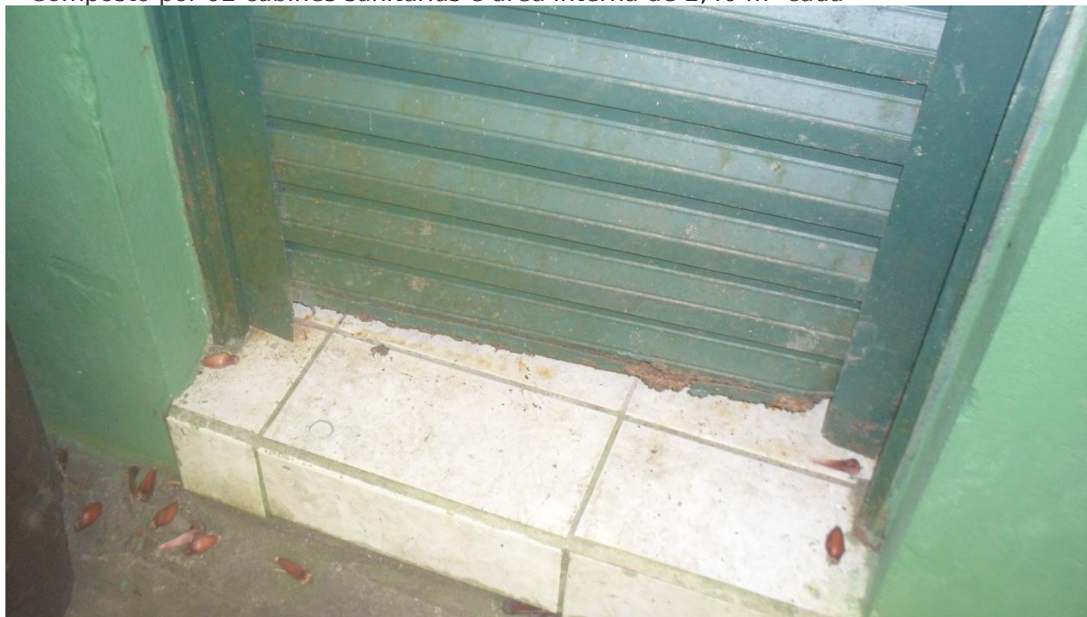
Figura 29 – Substituição da folha de porta em alumínio anodizado, pintura do batentes e sinalização dos sanitários
