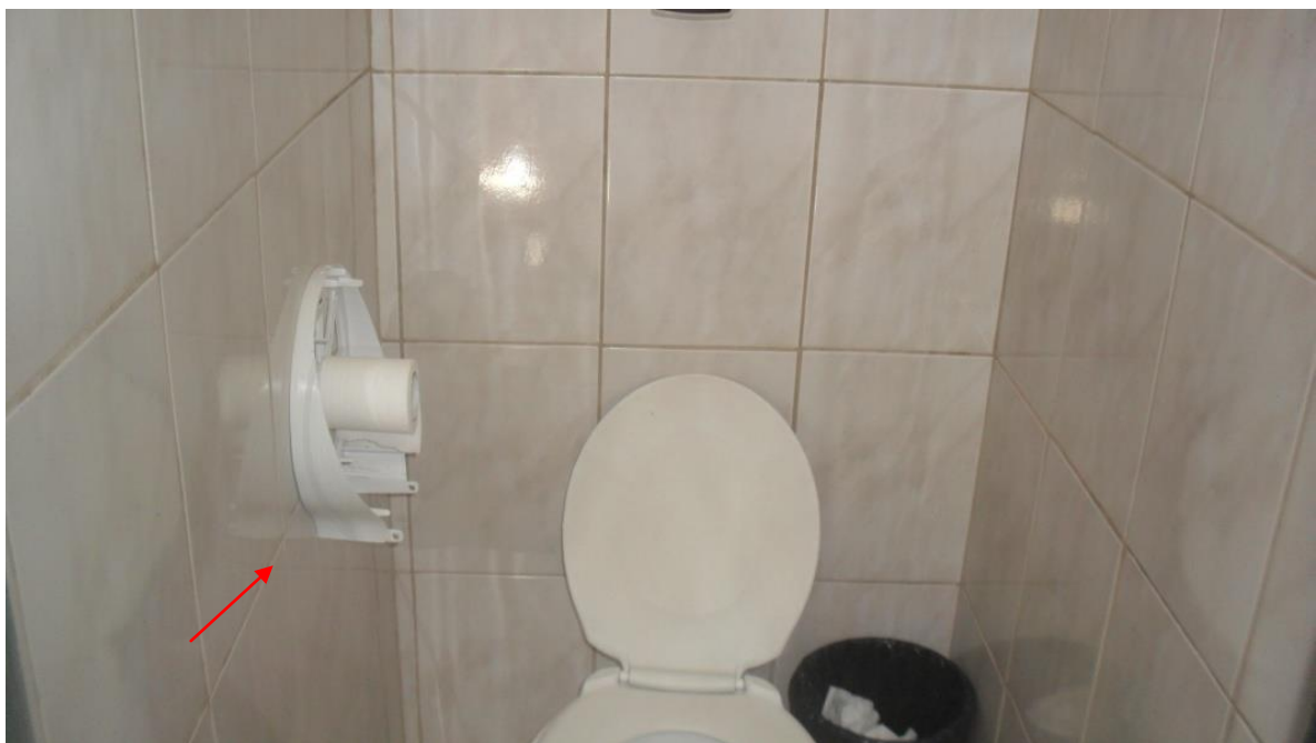
Figura 5 – Instalação de papelarias nas cabines sanitárias
