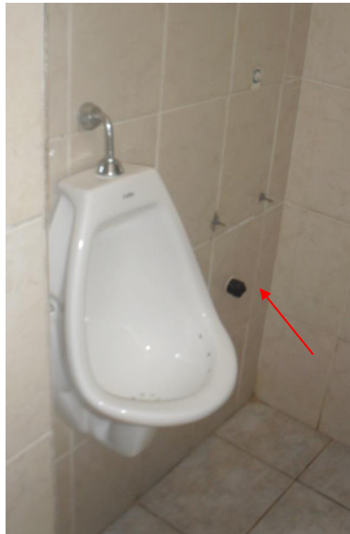
Figura 12 – Instalação de mictório
