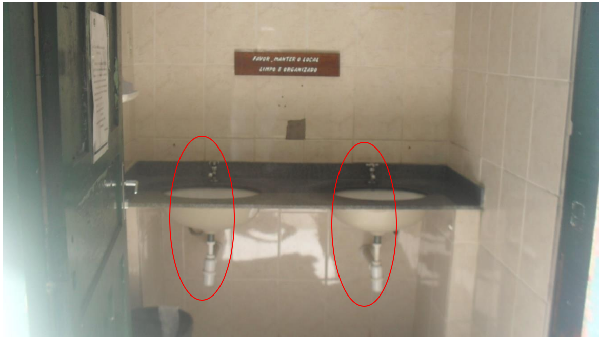
Figura 11- Substituição de torneiras e sifões, instalação de espelho, saboneteiras e toalheiros
