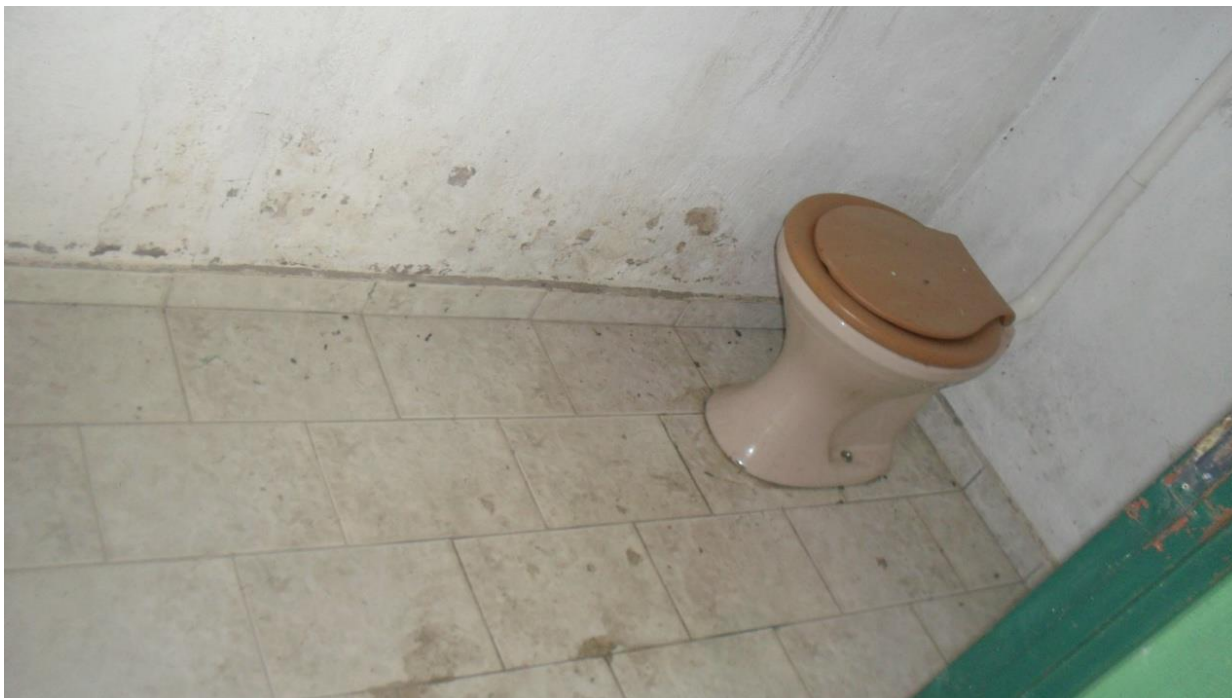
Figura 28 – Instalação de revestimento de parede e papelera
