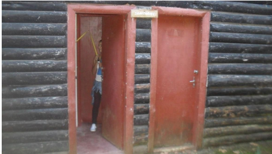
Figura 20 – Substituição das folhas de portas de entrada, reparo e pintura das guarnições existentes e sinalização indicando feminino e masculino
