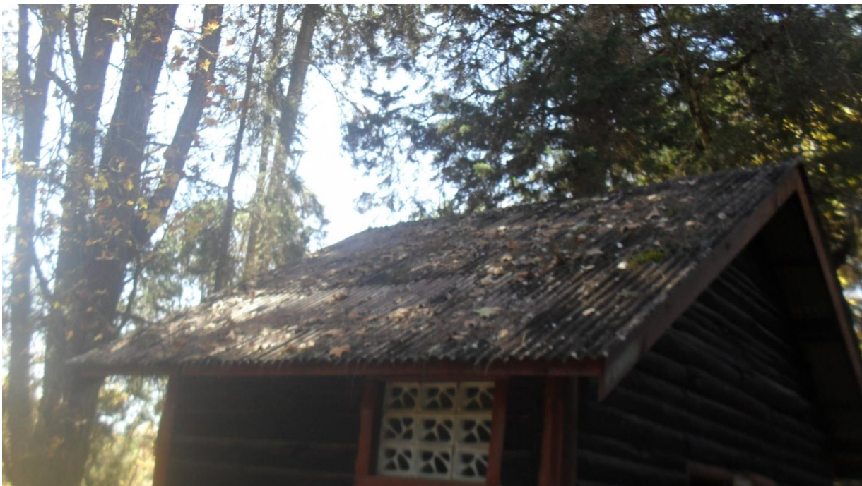
Figura 24 - Substituição das ripas e telhas de amianto por telhas cerâmicas francesas
