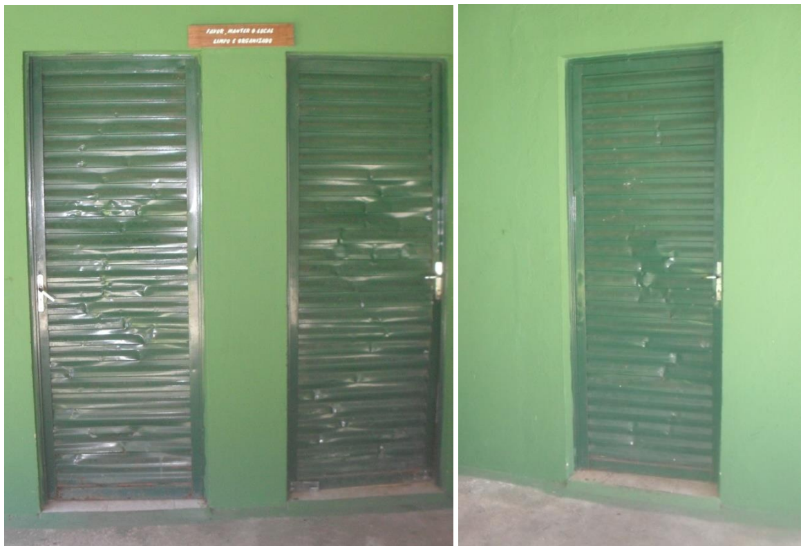
Figura 26 – Substituição de folhas de portas em alumínio do sanitário e do ambiente próximo, pintura dos batentes e sinalização dos sanitários
