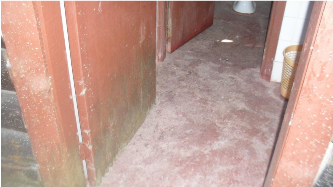
Figura 22 – Substituição das folhas de portas das cabines sanitárias
