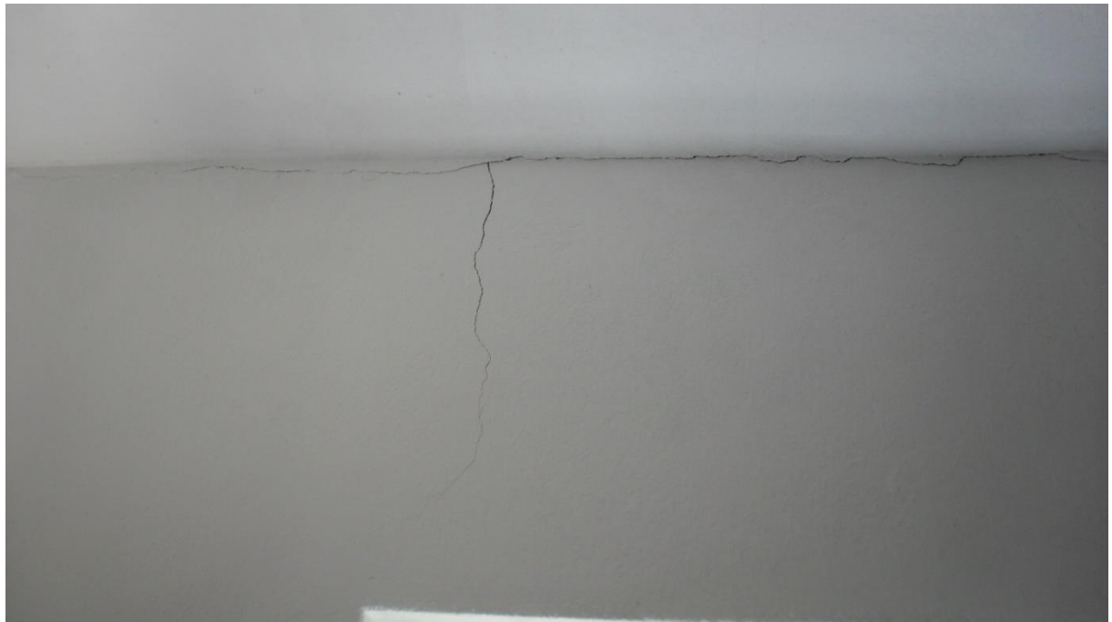
Figura 6 – Pintura da área interna
