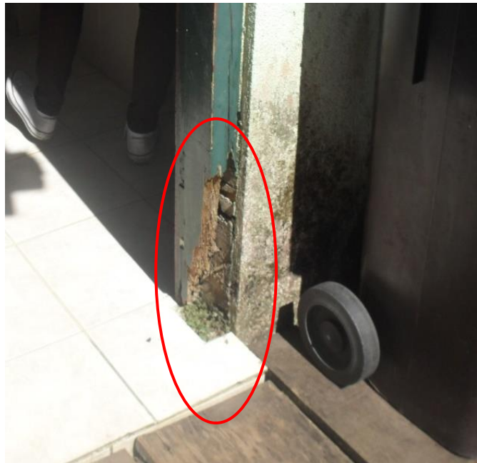
Figuras 7 e 8 – Substituição de porta e batente da entrada
