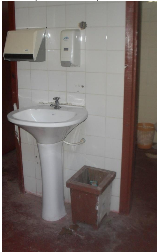
Figura 23 – Substituição de torneiras e sifões, e instalação de toalheiros e saboneteiras
