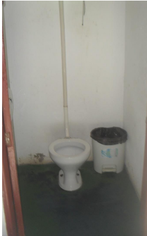
Figura 18 – Instalação de revestimento de parede, substituição da caixa de descarga para bacia sanitária com caixa acoplada com tampa e papeleira
