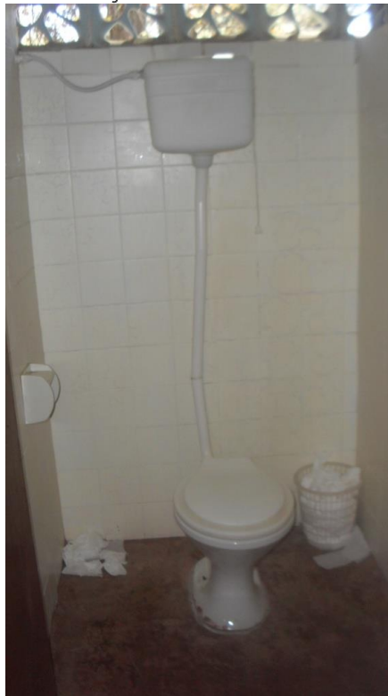
Figura 21 – Instalação de piso cerâmico, substituição da caixa de descarga para bacia sanitária com caixa acoplada com tampa, instalação de papeleira e remoção de pintura do revestimento de parede
