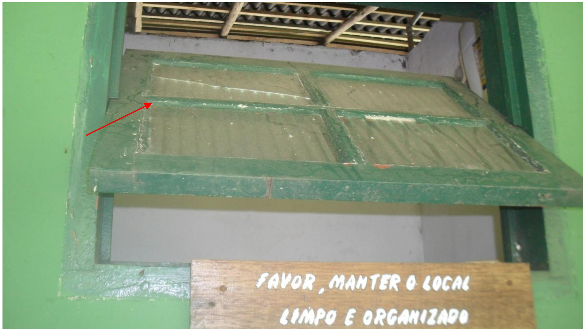
Figura 30 – Substituição do vidro quebrado e pintura da janela de madeira
