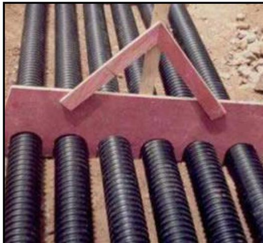
*Figura 2 - Eletroduto PEAD corrugado por fora e liso interno.*
