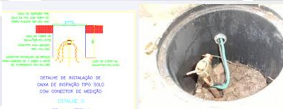
Figura 24 – exemplo de instalação da caixa de inspeção
