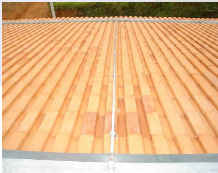
Figura 22 – Fita de alumínio instalada diretamente no telhado
