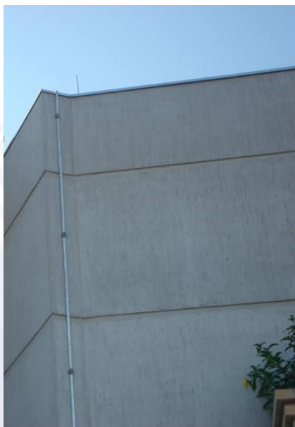
Figura 23 – Descida de fita de alumínio na parede.
