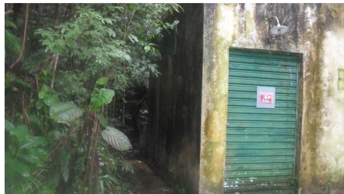
Foto 5 – Lateral esquerda da Casa do Transformador
