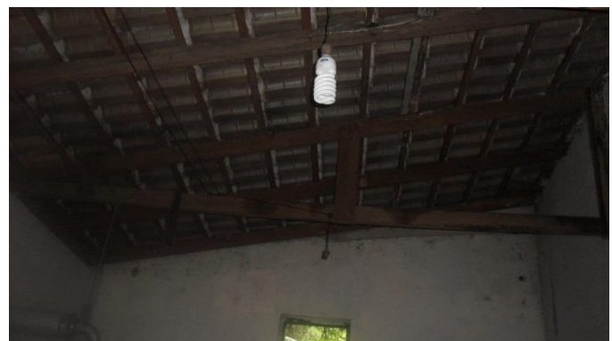
Foto 9 – Estrutura com ripas e caibros
