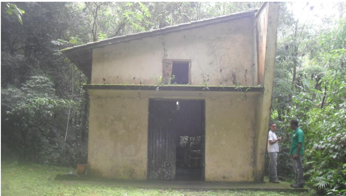
Foto 6 - Fachada Principal Casa dos Geradores
