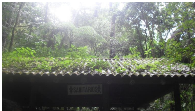
Foto 20 – Revisão telhas e cumeeiras e limpeza do telhado
