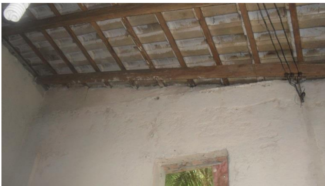
Foto 8 – Estrutura com ripas e caibros
