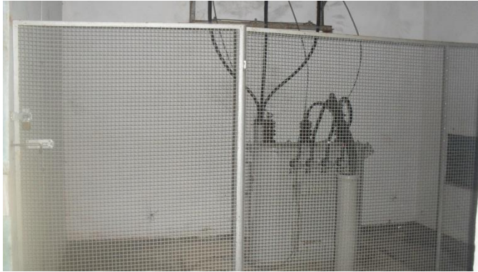
Fotos 2 e 3 – Transformador de tensão e grade de proteção
