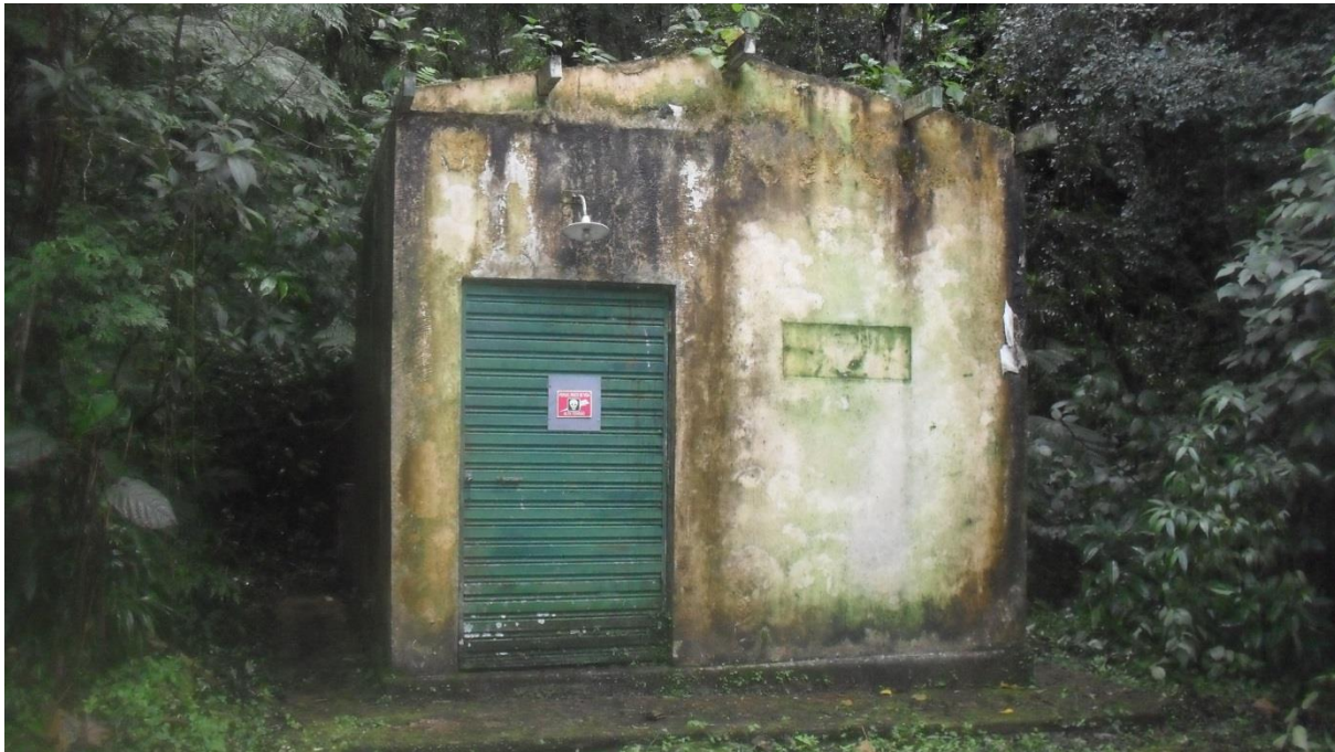
Foto 1 - Fachada Principal Casa do Transformador
