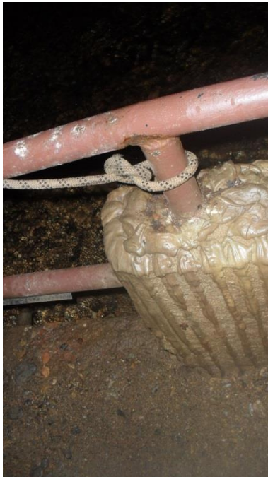
Fotos 30 e 31 – Improvisação com corda na ausência de parte do guarda-corpo
