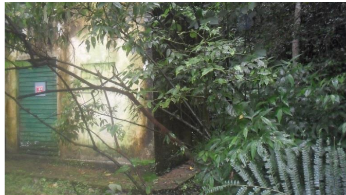
Foto 4 – Lateral direita da Casa do Transformador
