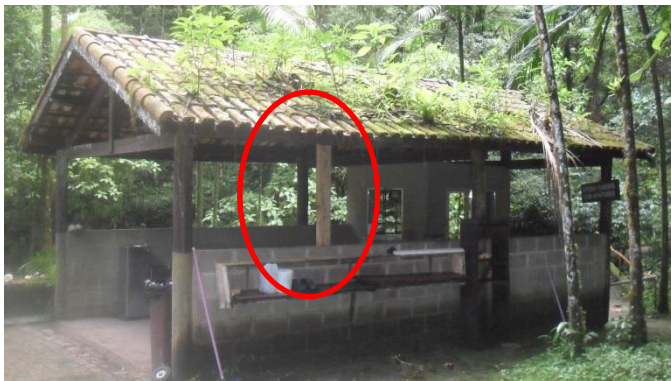
Foto 26 – Escoramento provisório da estrutura. Vãos assimétricos
