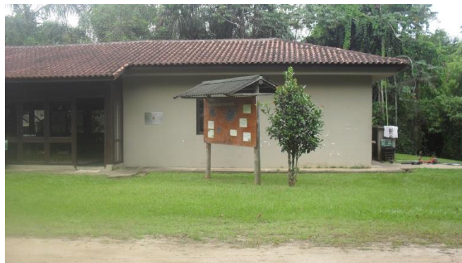
Foto 3 – Revisão de telhas e cumeeiras
