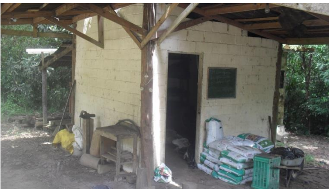
Foto 51 – Pintura das alvenarias
