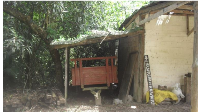
Foto 55 – Substituição das telhas
