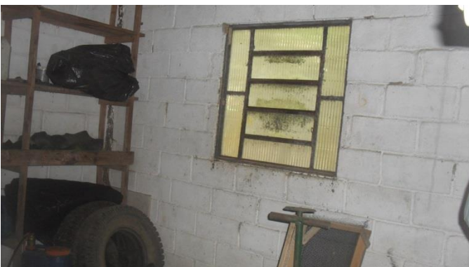
Foto 53 – Pintura interna e da esquadria
