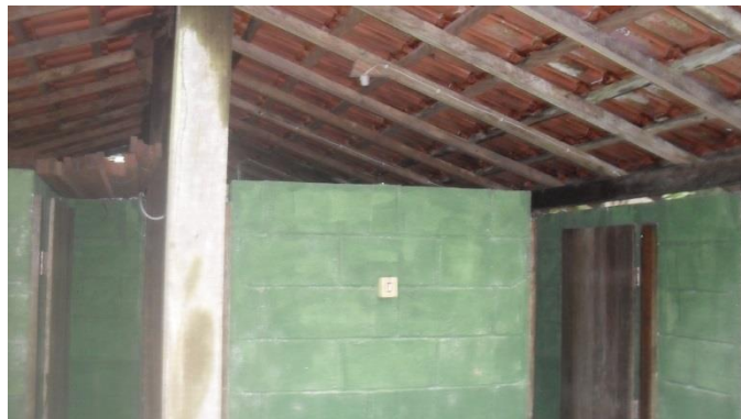
Foto 75 – Superfícies em madeira deverão ser pintadas
