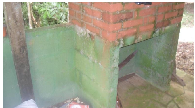
Foto 67 – Preparo da base e pintura em tinta acrílica
