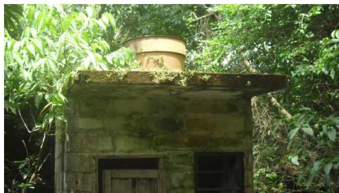
Foto 51 – Impermeabilização da laje
