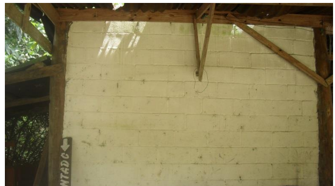
Foto 57 – Pintura da alvenaria
