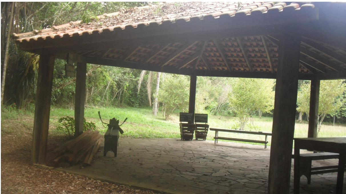
Foto 64 – Cobertura sextavada sobre piso em pedra
