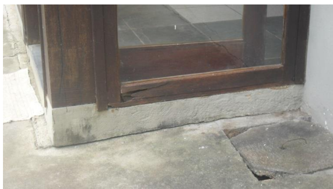
Foto 6 – Executar uma nova tampa de concreto
