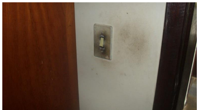
Foto 30 – Substituir interruptores e tomadas
