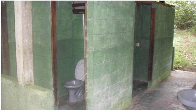
Foto 74 – Alvenaria externa e interna dos boxes em bloco pintado
