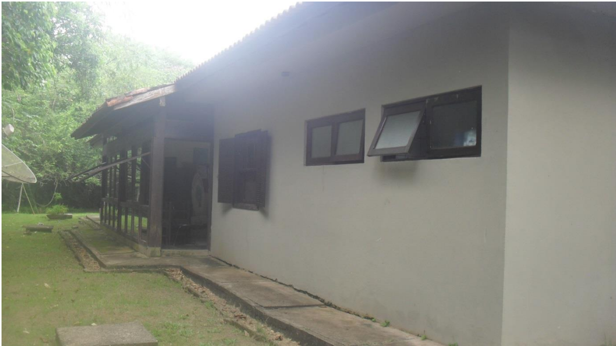
Foto2 - Fachada de Fundo do Centro de Visitantes/Base de Vigilância
