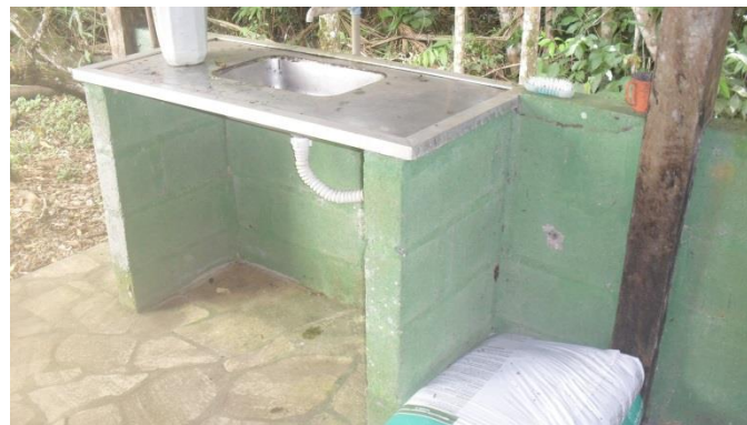
Foto 66 – Reparos de hidráulica na pia
