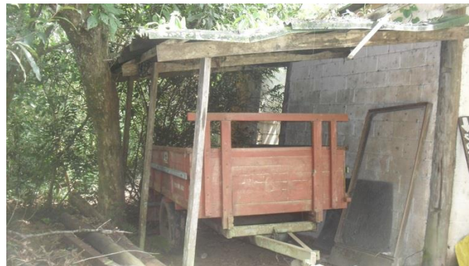
Foto 56 – Adequação da estrutura de madeira
