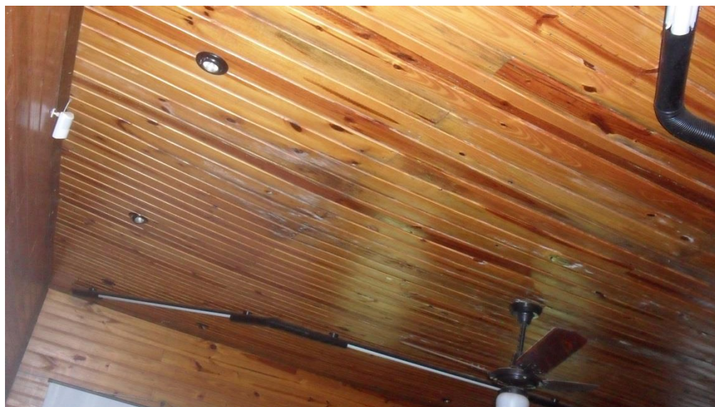
Foto 17 – Forro e parede não tratados contra cupim
