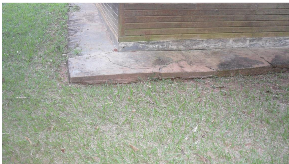
Foto 7 – Recalque da calçada
