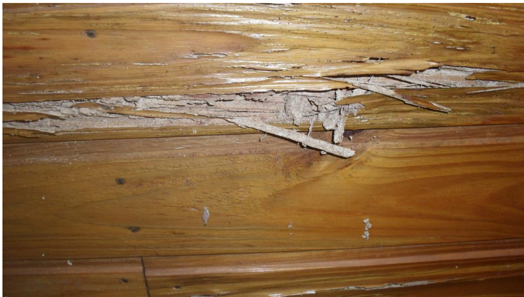
Foto 12 – Ataque de cupins consumindo a celulose da madeira
