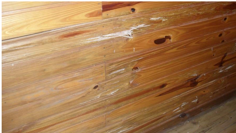
Foto 13 – Ataque de cupins consumindo a celulose da madeira
