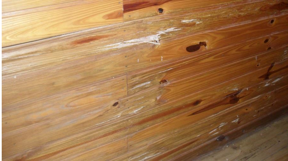
Foto 13 – Ataque de cupins consumindo a celulose da madeira
