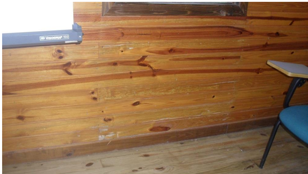
Foto 14 – Ataque de cupins consumindo a celulose da madeira
