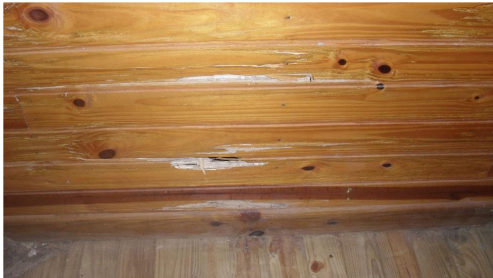
Foto 16 – Ataque de cupins consumindo a celulose da madeira
