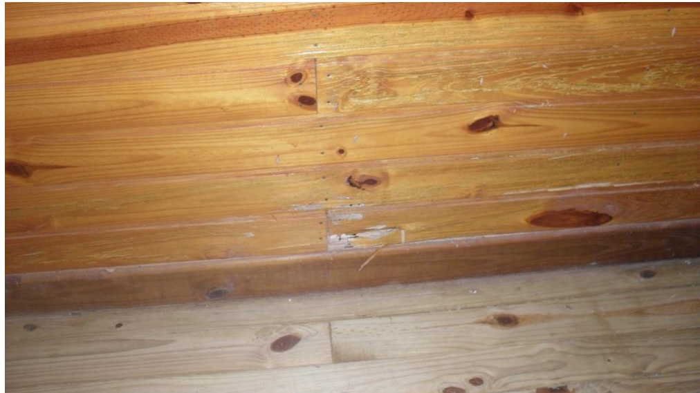
Foto 15 – Os montantes para emenda e pregação a cada 1m
