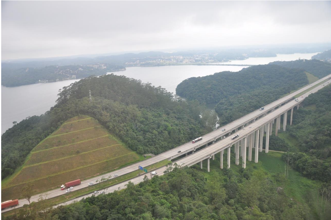
Figura 9. Cortes, aterros e obras de arte em sub-trecho do Rodoanel Sul, implantado no Riacho Grande
