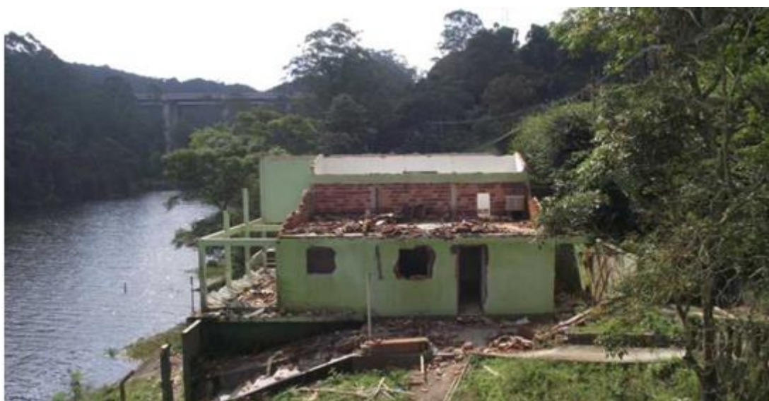
Figura 12. Casas situadas à beira da Represa Billings e que foram desapropriadas pelo DERSA. Ao fundo, trecho do Rodoanel
