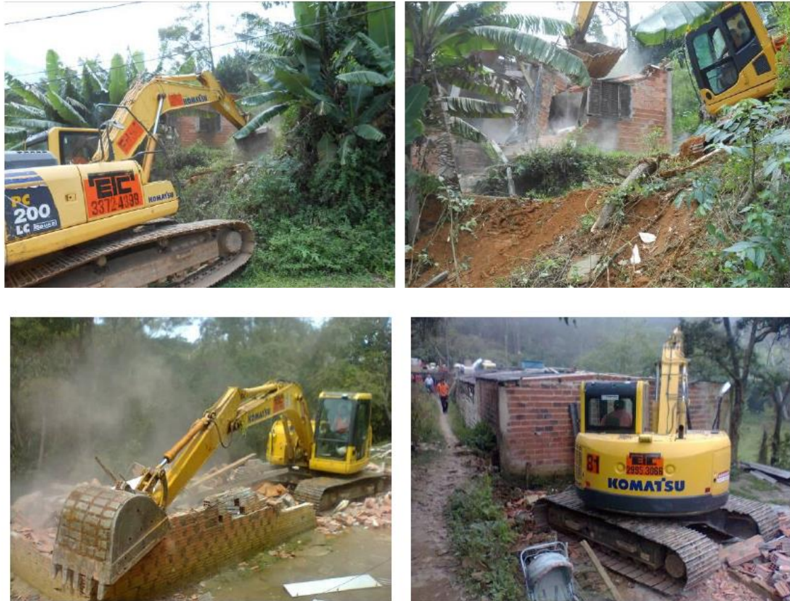
Figura 11. Demolição de antigas construções e limpeza dos terrenos
