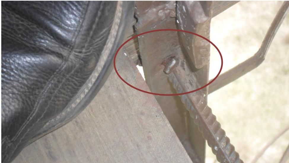
Foto 12 – Parafuso solto na fixação da estrutura
