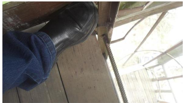
Foto 11 – Parafuso solto na fixação da estrutura
