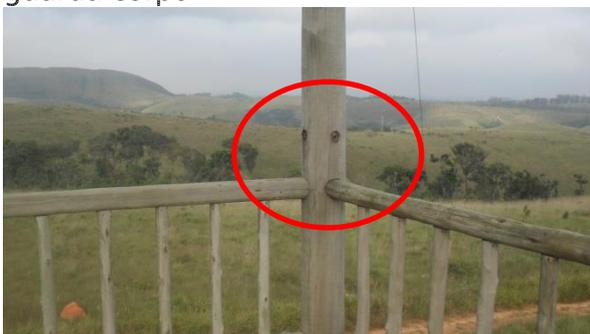
Foto 38 e 39 – Ausência da peça superior do guarda corpo
