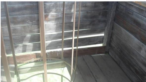
Foto 5 – Deformação das tábuas de parede montante
