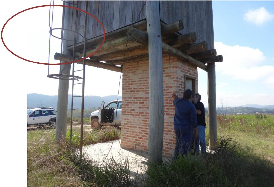
Foto 9 – A proximidade do degrau com a parede não permite apoio dos pés
