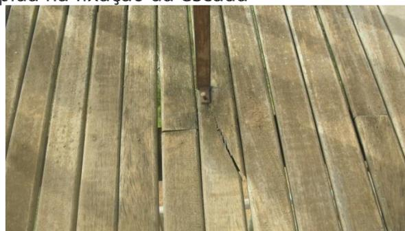
Foto 32 – Solda rompida na fixação da escada
