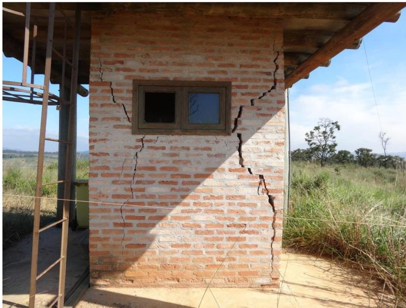
Foto 46 – Sanitário com paredes trincadas
