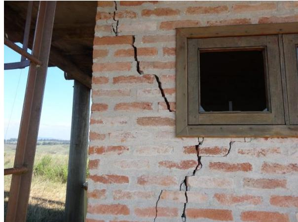
Fotos 47 e 48 – As grandes trincas comprometeram a estabilidade
