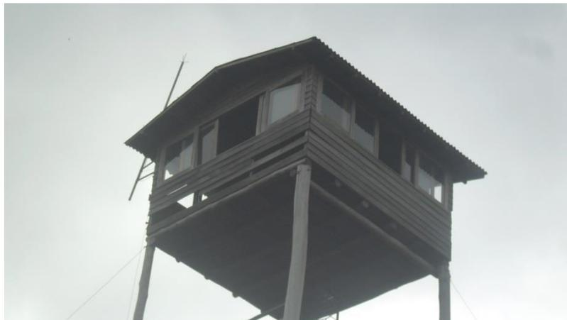
Foto 56 – Fixação deficiente do para-raios
