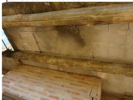
Foto 52 – Armadura exposta da laje maciça
