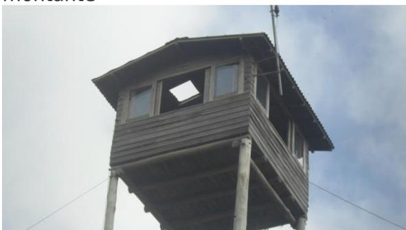
Foto 7 – Deformação na 1ª telha e alçapão aberto
