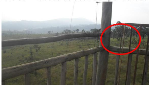
Foto 37 – Ausência da peça superior do guarda corpo
