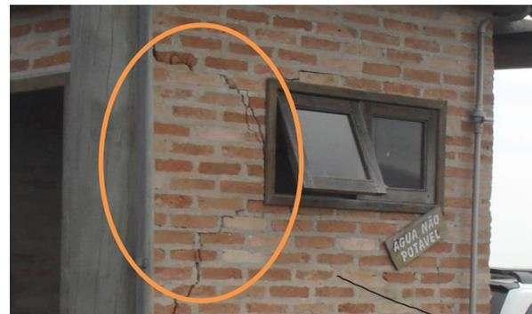
Fotos 22 e 23 – As grandes trincas comprometeram a estabilidade
