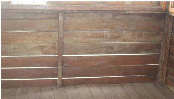
Foto 26 – Deformação das tábuas de parede
