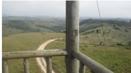
Foto 14 – Ausência da peça superior do guarda corpo
