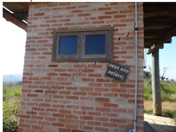
Fotos 49 e 50 – Sanitário com paredes trincadas
