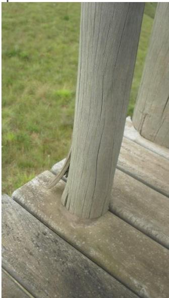
Foto 17 – Substituir peça vertical do guarda corpo
