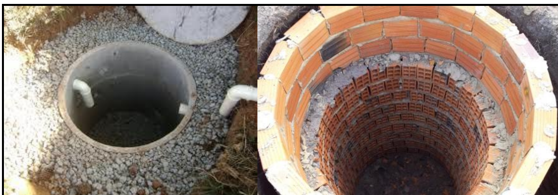
Figura 9 – Exemplo de sumidouro de pré-moldado e de alvenaria.
