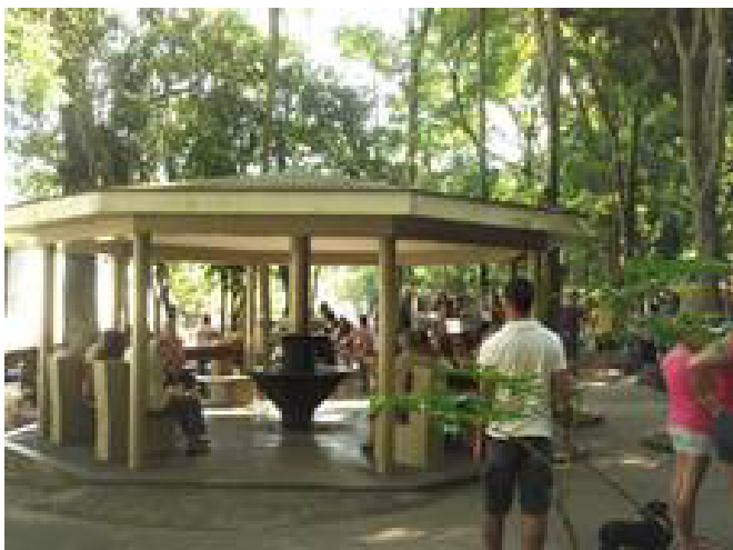
Figura 32 – Estrutura de acesso ao Fontanário Fonte Villela
