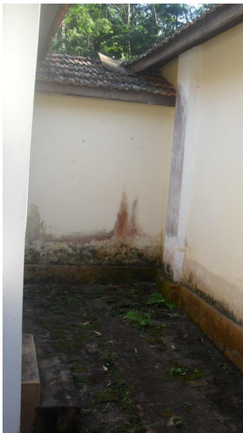
Fotos 35 e 36 Umidade pela queda da água do beiral curto
