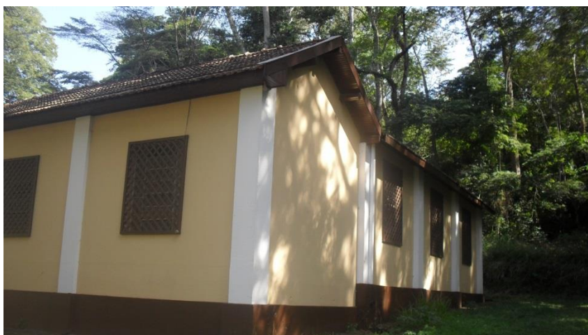
Foto 23 – Rufo dobrado entre a telha e a tabeira
