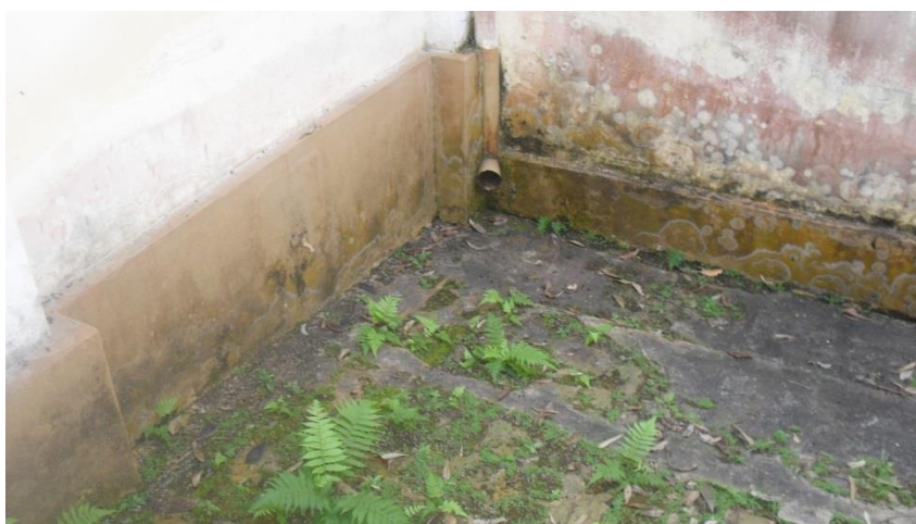
Foto 45 – Piso do pátio menor – limpeza e recuperação
