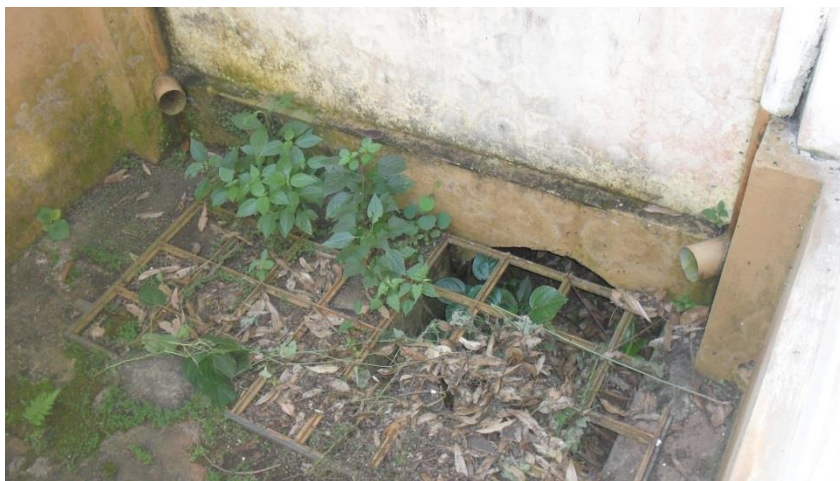
Foto 18 – Galerias obstruídas por excesso de folhas e vegetação se desenvolvendo
