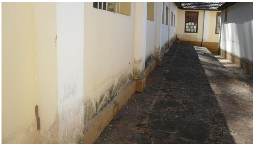
Foto 43 – Piso externo do Pátio em tijolos de barro
