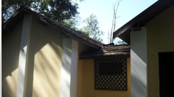
Foto 2 e 3 – Configuração do telhado
