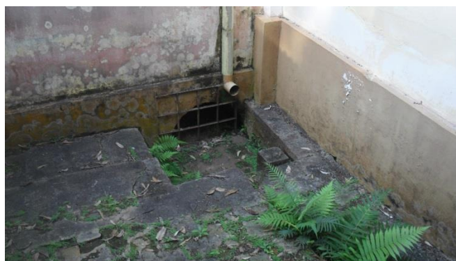
Fotos 35 e 36 Umidade pela queda da água do beiral curto
