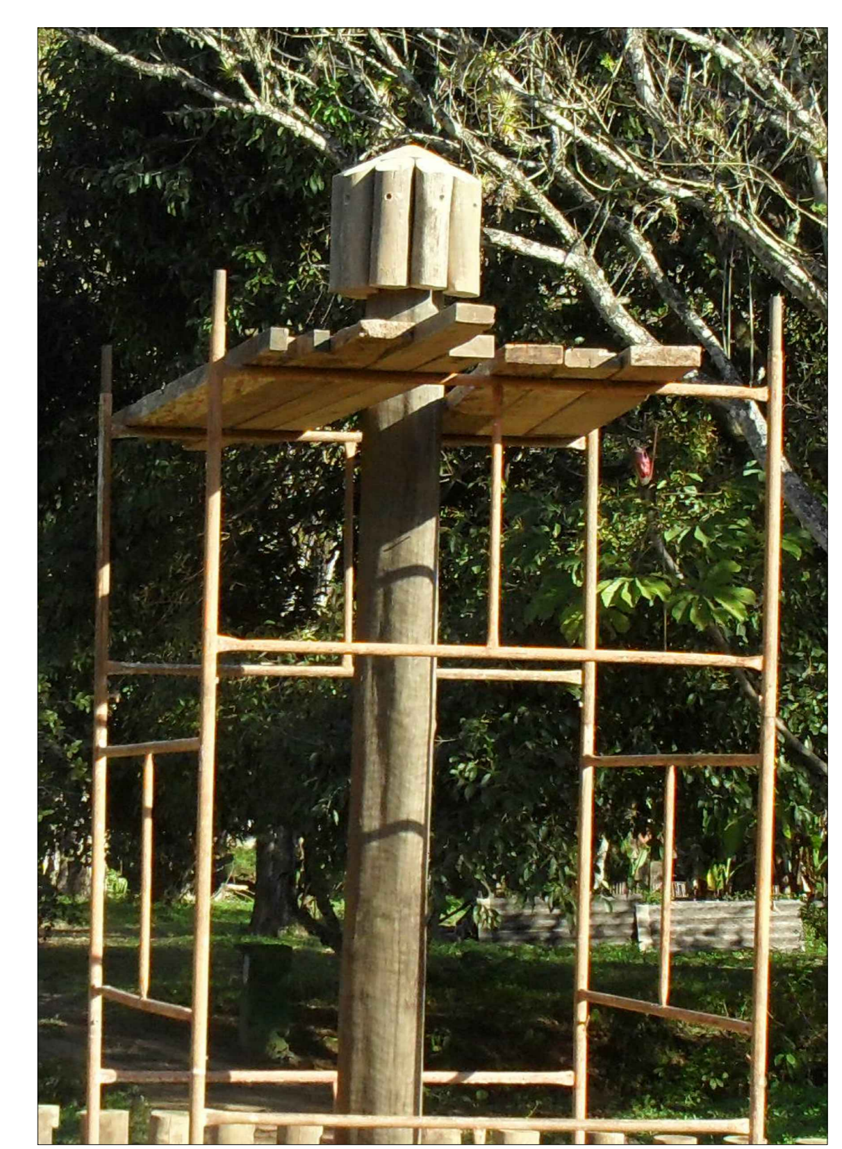
Modelo de reforço para apoio dos caibros
