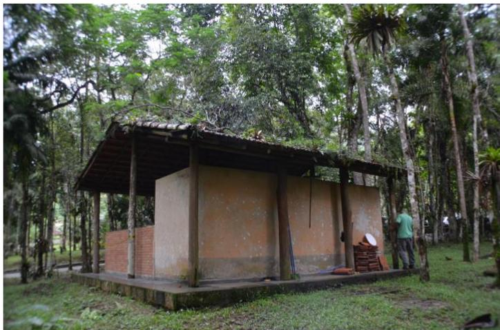
A primeira medida a ser tomada consiste em calçar alguns pilares para que a estrutura suporte o peso de pessoas sobre o telhado para dar início ao processo de destelhamento e retirada das peças de madeira (ripas, caibro e vigas).
