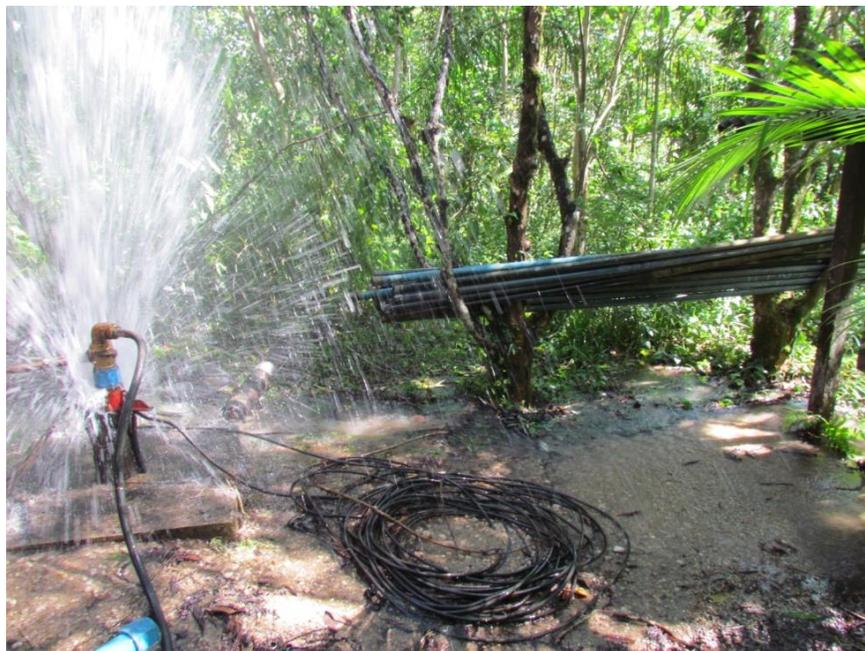
**Figura 2:** Canos de PVC retirados do poço e bombeamento da água para limpeza.
