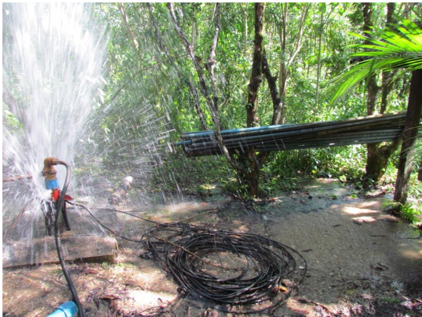
Figura 1: Limpeza e manutenção do poço semi artesiano.
