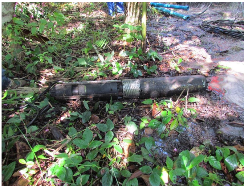
Figura 4: Bomba d'água retirada do poço.
