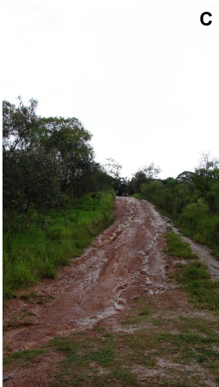
Foto 6. Processos erosivos relacionados à ocupação antrópica: deslizamentos (A e B) e erosão linear (C e D).
