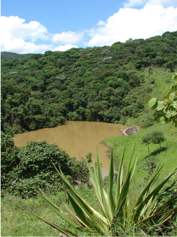
Foto 13. Represa e Barragem do Tanque Grande. Fonte: Angela Pellin
