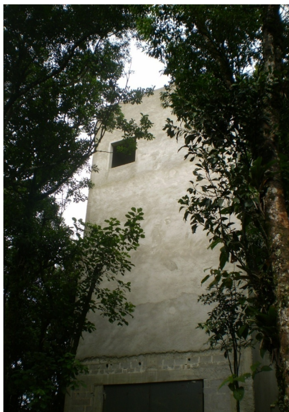
Foto 7. Torre no Mirante da Pedra Preta. Fonte: Própria
