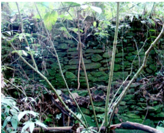
Foto 17. Muro histórico de Pedras Secas. Fonte: Guarulhos 2008
