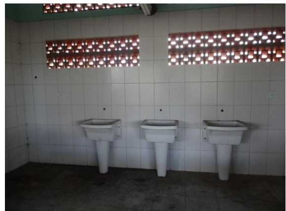
Área dos tanques (sem torneira)
