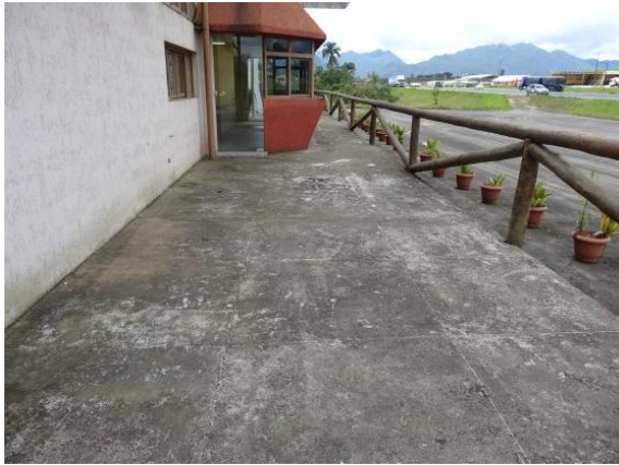
Piso da área externa
