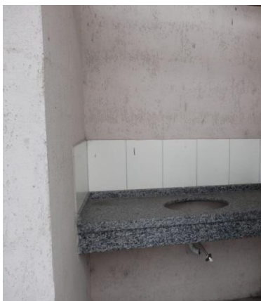
Bancada – Banheiro Lado Externo
