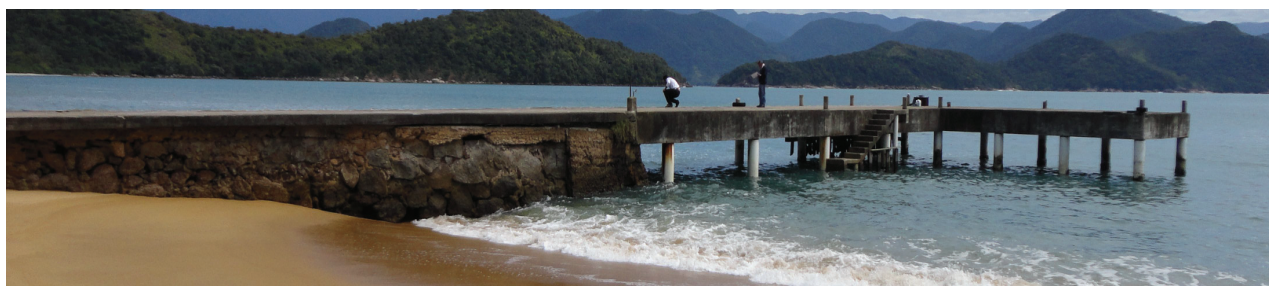
Figura 1.4. Vista em perspectiva da lateral leste do píer – PEIA.
