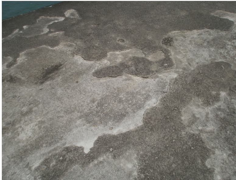
Figura 6.3. Detalhe do piso existente da plataforma.
