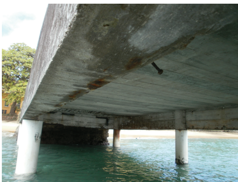
Figura 6.6. Vista geral inferior da estrutura de concreto armado.
