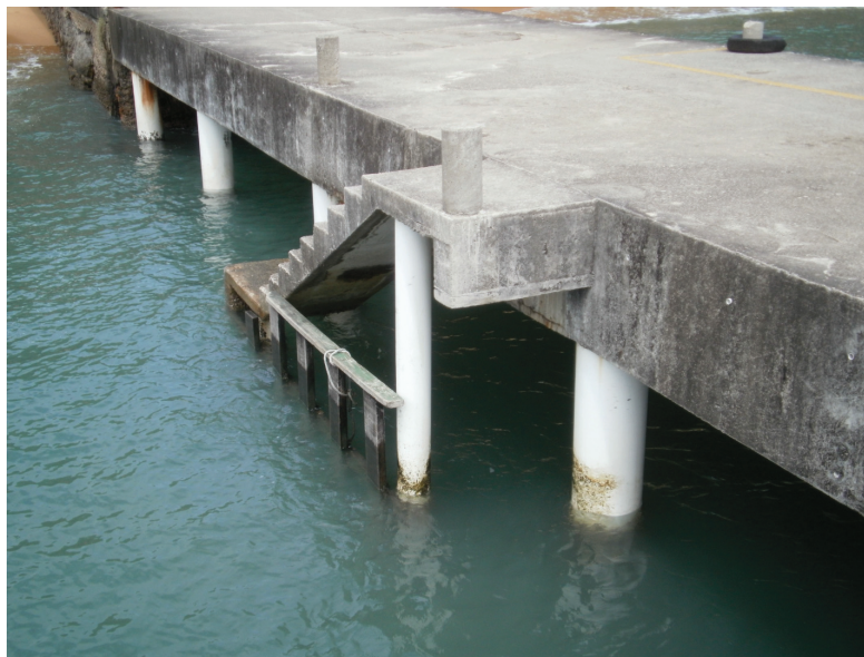
Figura 6.4. Vista da estrutura da escada de acesso.
