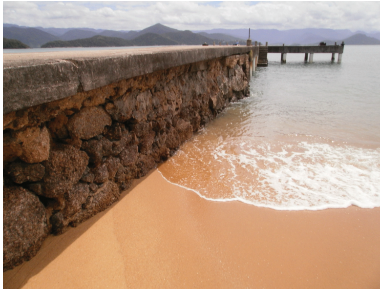
Figura 6.1. Detalhe do enrocamento lateral.
