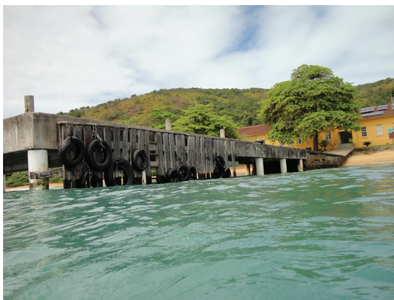
Figura 6.10. Vista da estrutura de amortecimento utilizada para apoio das embarcações.
