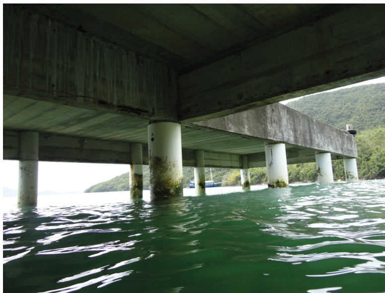
Figura 6.9. Vista inferior da estrutura de concreto.
