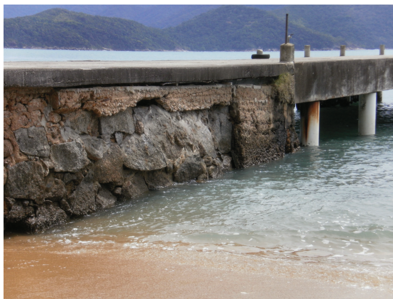
Figura 6.2. Detalhe do enrocamento e estrutura lateral.
