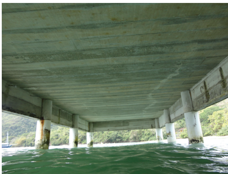
Figura 6.8. Vista inferior da estrutura de concreto.
