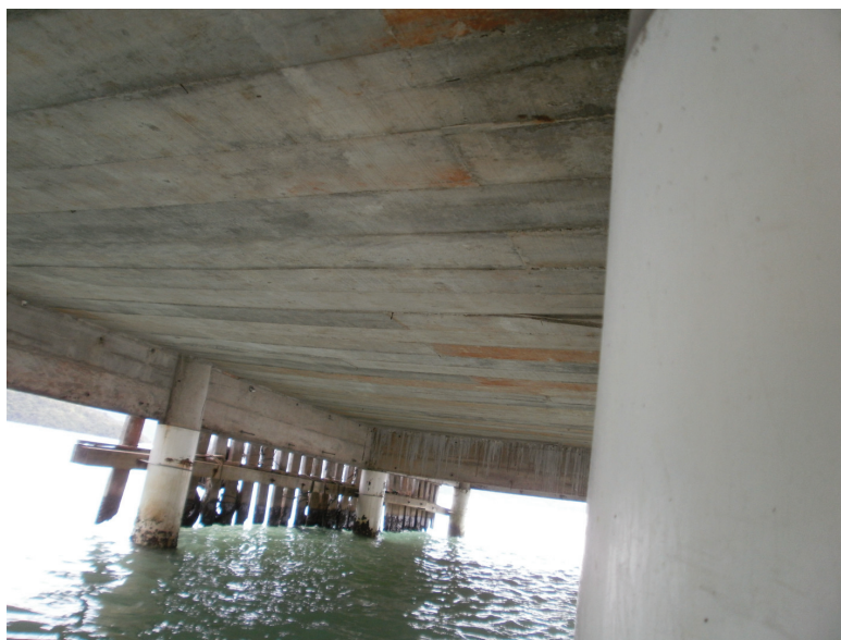
Figura 6.7. Vista geral inferior da estrutura de concreto armado.
