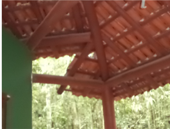
Foto 7: necessidade eminente de manutenção da cobertura existente com reposição de telhas e peças estruturais necessárias.
