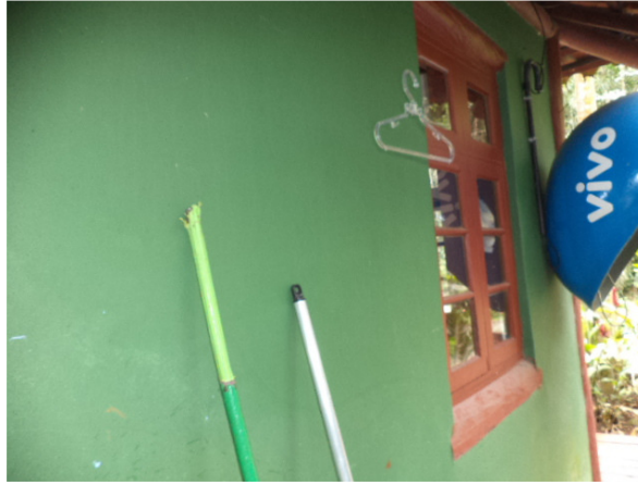
Foto 9: fachada na qual serão instalados caixilhos de Bilheteria
