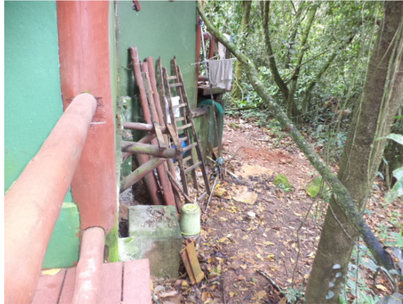
Foto 5: entulhos e materiais não utilizados deverão ser removidos
