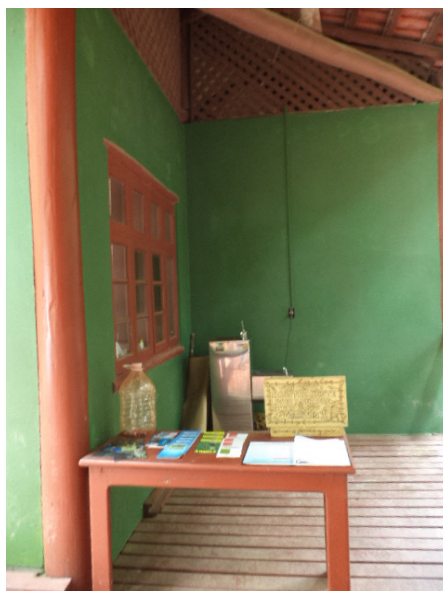
Foto 2: área em que será construído sanitário acessível. Atentando-se à necessidade de retirada do caixilho a esquerda da imagem.
