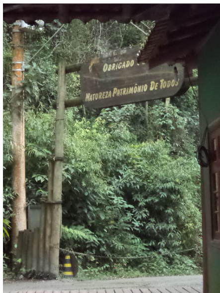
Foto 1 : Portal atual deverá ser reformado nos padrões da Fundação Florestal.
