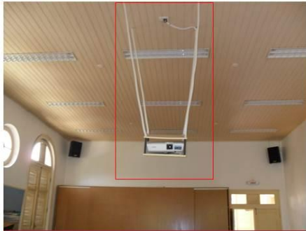
Instalar suporte datashow e eletrocalha - figura 1.
