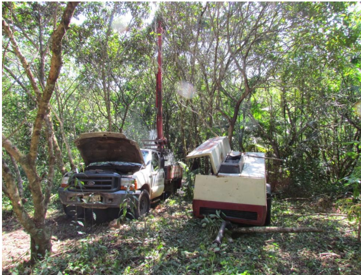
Figura 1: Limpeza e manutenção do poço semi artesiano.
