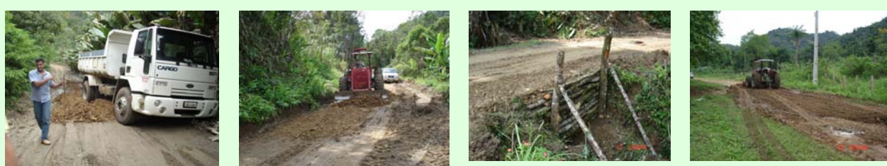
Reparos emergenciais na estrada do Despraiado em 2008
