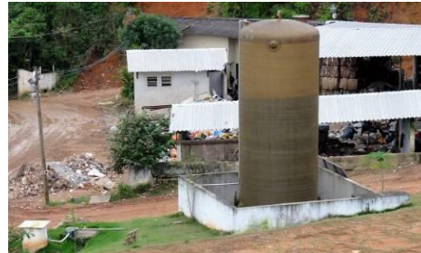
Caixa de armazenamento do chorume
