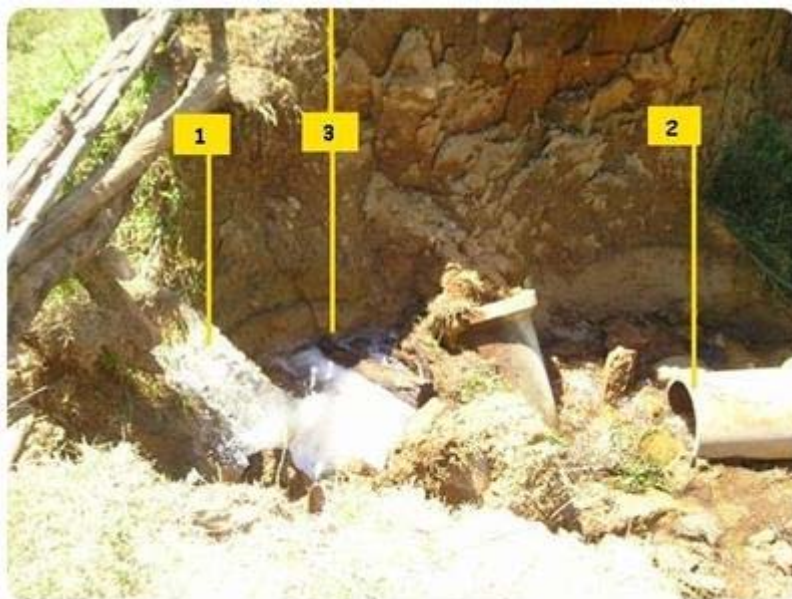
Figura 6 - Estado de deterioração do Vertedouro do “Lago 3”, em 07/12/2008.
