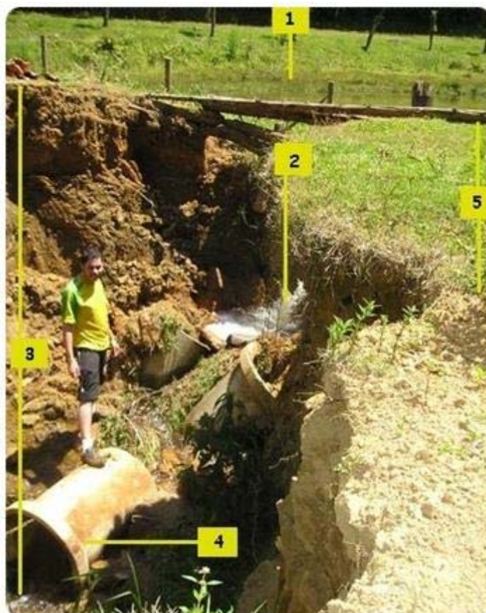
Figura 7 - Estado de deterioração do Vertedouro do “Lago 3”.
