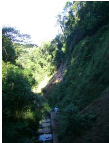
E/AC 03 – Erosão intensa em canal fluvial a jusante da Área de Empréstimo. Processo causado pela concentração do escoamento fluvial que destrói as estruturas de contenção implantadas e provoca escorregamentos planares e solapamento nas margens íngremes do canal.
