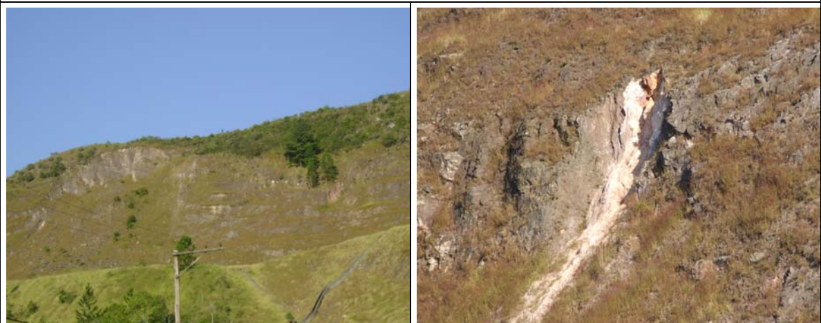
E 02 – Área de empréstimo da duplicação da Rodovia Fernão Dias em recuperação, porém com recorrência de pequenos escorregamentos e erosão superficial.
