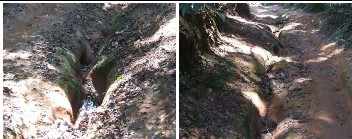
E 01 – Erosão em sulcos e ravinas na Trilha do Pinheirinho.
