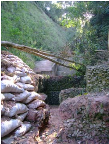
E/AC 03 – Erosão intensa em canal fluvial a jusante da Área de Empréstimo. Processo causado pela concentração do escoamento fluvial que destrói as estruturas de contenção implantadas e provoca escorregamentos planares e solapamento nas margens íngremes do canal.
