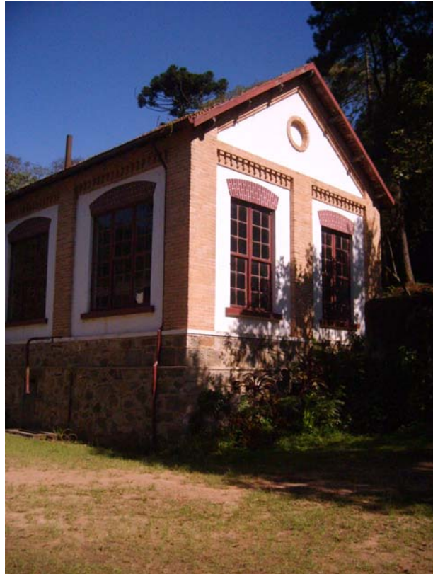
Figura 10 – Casa da Bomba
