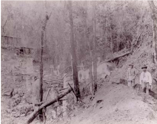
Construção do Aqueduto – 1893
