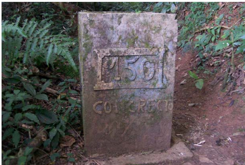
Caixa de Concreto julho 2008
