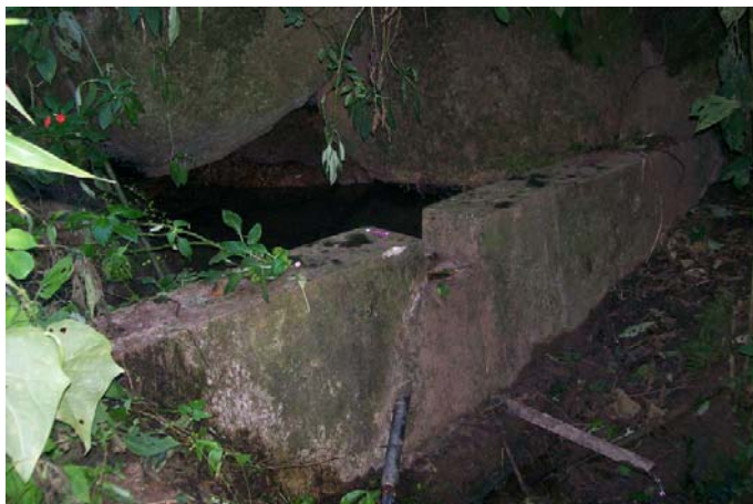
Foto Represa do Depósito julho 2008
