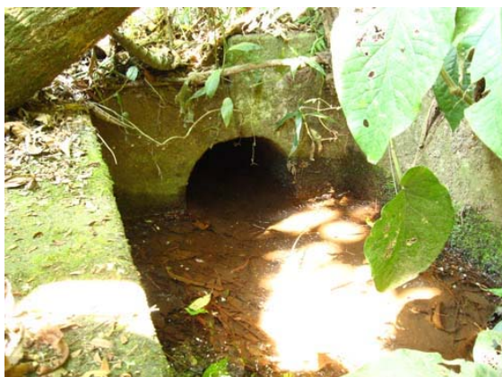
Foto 2007 aqueduto em alvenaria 500mm de diâmetro
