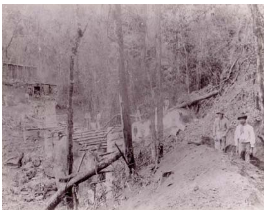
Construção do Aqueduto – 1893
