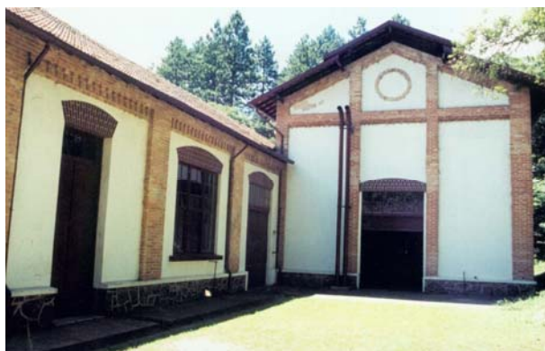
Casa da Caldeira e Casa da Bomba Secundária
