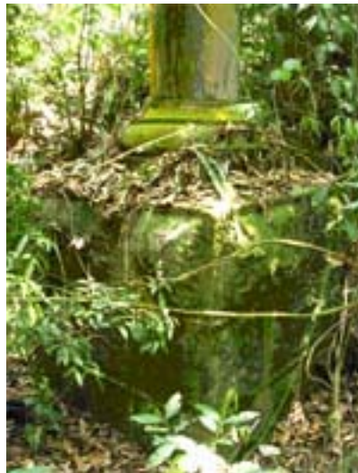
Foto 2007 - Detalhe de uma das pilastras
