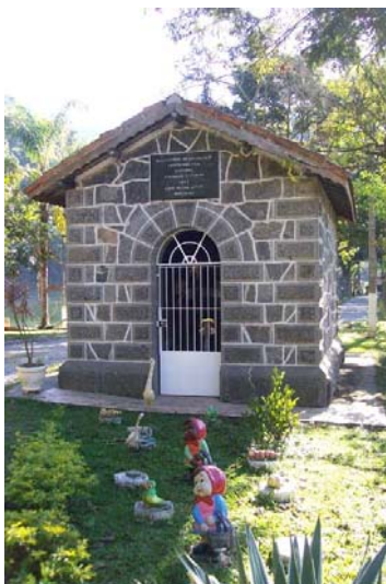
Vista frontal da Casa de Manobras junho 2008
