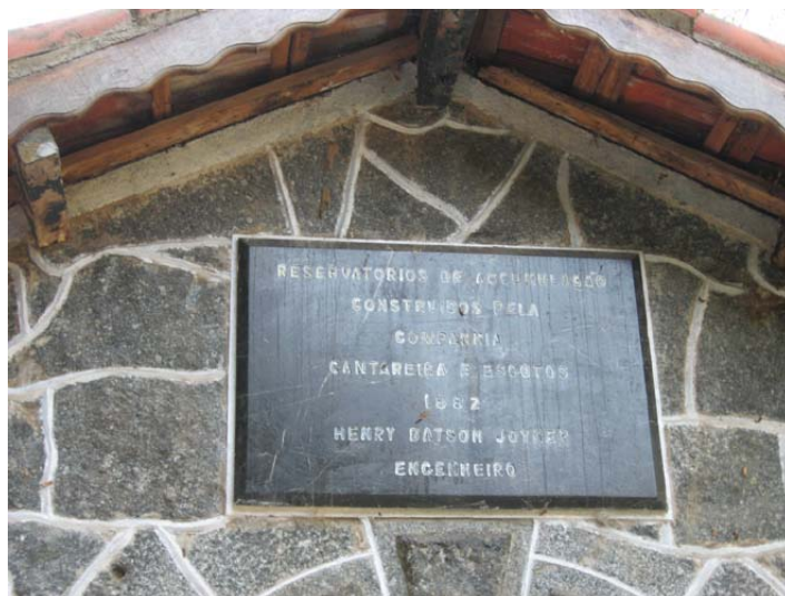
Placa afixada na Casa de Manobras junho 2008
