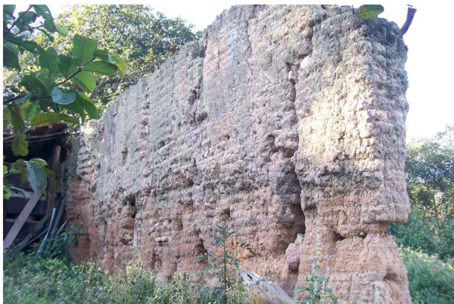
Estrutura em frente a sede da fazenda julho 2008
