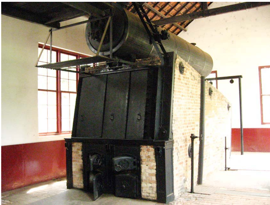
Vista interna Casa da Caldeira
