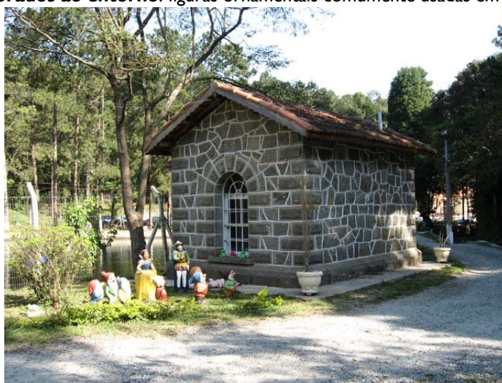
Casa de manobras e entorno
