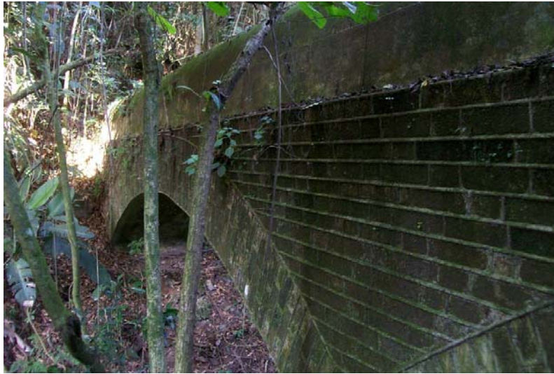
Trecho do Aqueduto julho 2008
