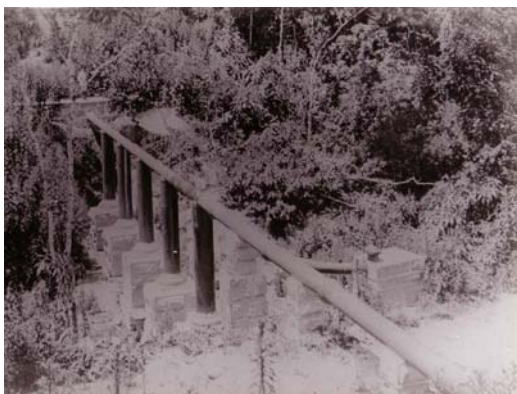
Foto P. Doumet 1894 Aqueduto em tubos de ferro
