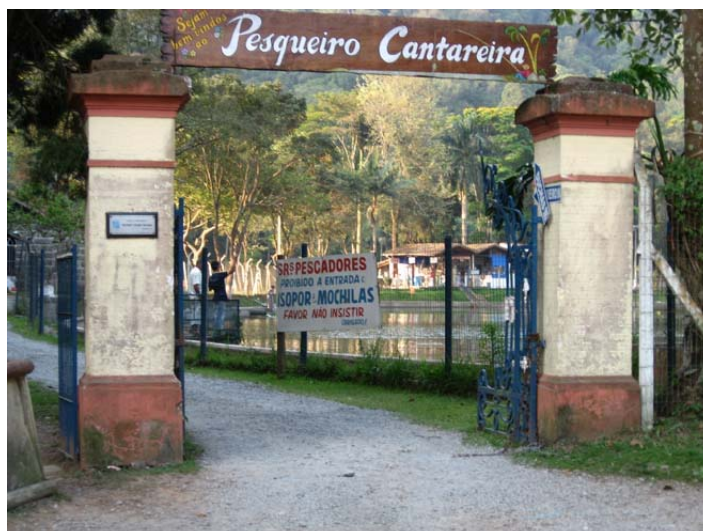
Entrada do Clube da SABESP. Reservatórios de Acumulação A e B UTM 334216 7406564
