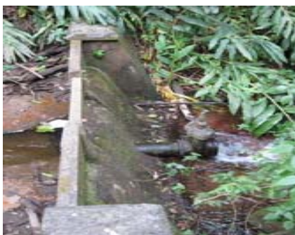
Pequena barragem que fazia parte do antigo complexo do Guaraú – 2007
