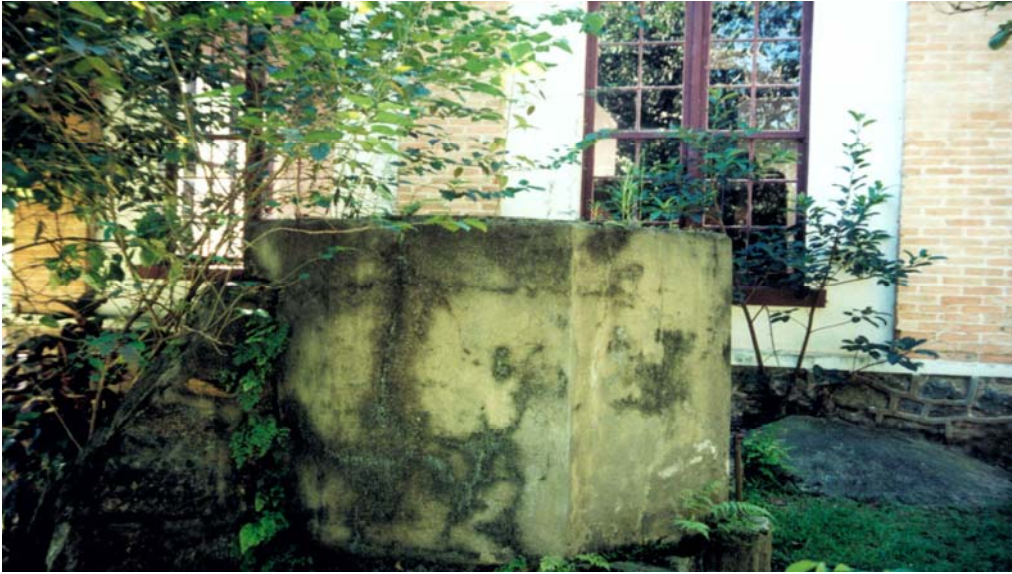
Base da chaminé ao lado Casa da Caldeira
