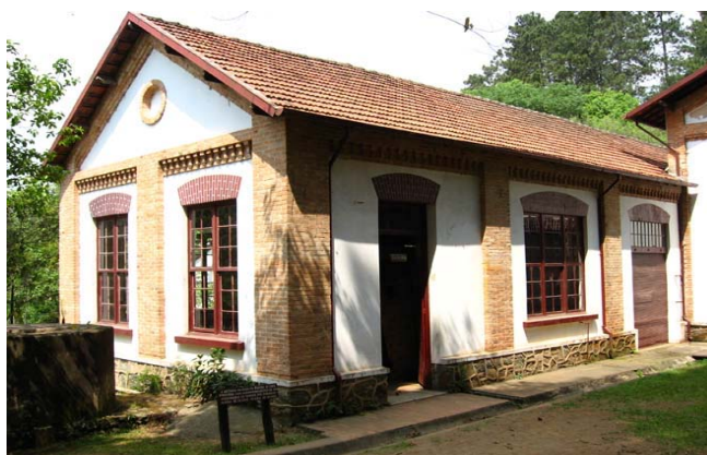
Casa da Caldeira à esquerda estrutura da chaminé outubro de 2007
