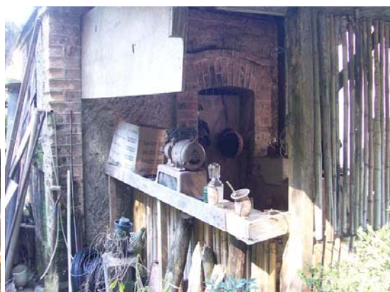
Caixa do Sifão no I vista parcial
