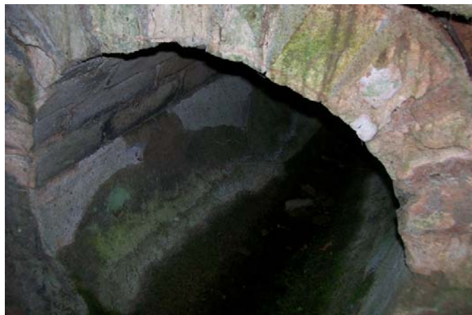
No detalhe: Parte inferior em radier e a superior em tijolos julho 2008
