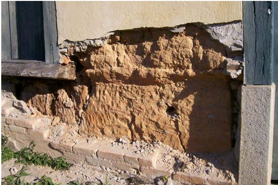
Detalho da estrutura em taipa
